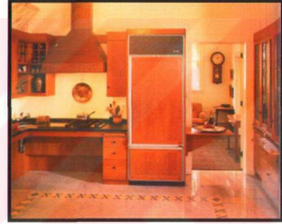
Resim 2.7. Lavabonun ve Ocağın Tekerlekli Sandalye Kullanıcısı Tarafından Kullanılabilmesi İçin Yapılan Düzenleme 56
