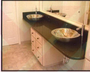
Resim 2.7. Lavabonun ve Ocağın Tekerlekli Sandalye Kullanıcısı Tarafından Kullanılabilmesi İçin Yapılan Düzenleme 56
