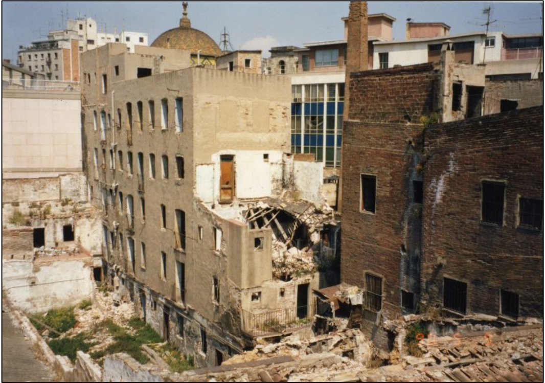
Resim 15. Binaların fiziksel yenilemeden önceki durumu
