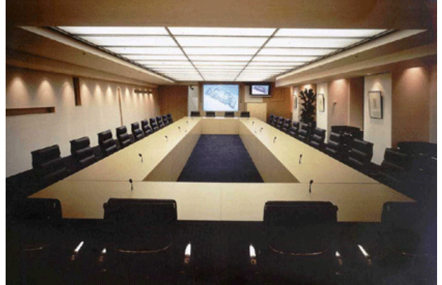
Resim 2.2. Toplantı Odasında uygulanan aşağı doğru aydınlatma sistemi
