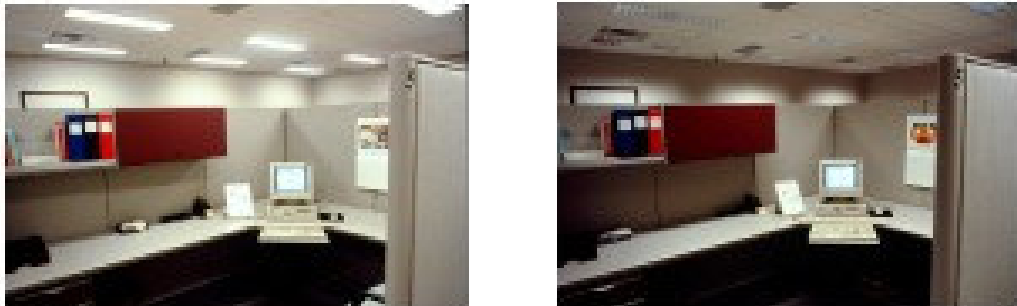
Resim 3.12. Direk Ve Endirekt Aydınlatma Sistemi İle Aydınlatılan Ofis Mekanı Ve İki Mekan Arasındaki Parlaklık Ve Aydınlatma Farklılıkları
