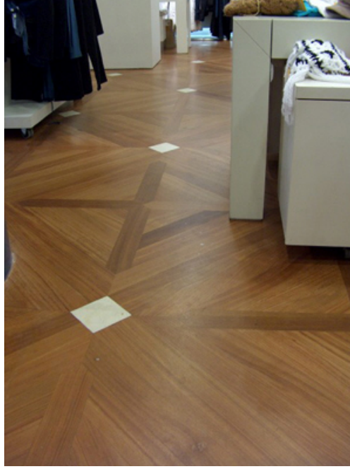
Resim 3. 38. Bağdat Caddesi üzerindeki Vakko mağazasında doğal ahşap döşeme ile oluşturulan farklı zemin kaplaması (Fotoğraf. Ö. ÖRSÇELİK)
