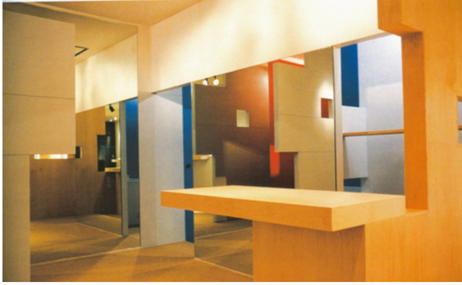
Resim 3. 46. Lello Bacio bayan ayakkabı mağazasında, yapay ahşap üzeri kaplama kullanılan pano düşey bölücüler. (S. Cliff, “50 trade secrets of great design, retail spaces, Rockford, Publishers”, Massachusetts,1999, s.183)
