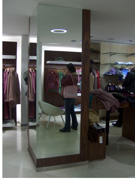
Resim 4. 31. Atalar bayan giyim mağazasının ayna, santos kaplanmış MDF ve aydınlatma elemanı ile kaplanan kolonlardan biri (Fotoğraf. Ö. ÖRSÇELİK).
