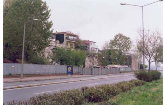
Resim 4.65. 31. ve 32. kuleler arasındaki duvar M. Özçakı
