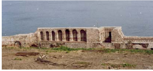
Resim 4.38. Sur duvarının iç bölümünde yer alan hafifletme kemerleri M. Özçakı
