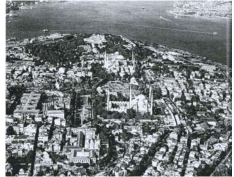
Resim 3.7. Sultanahmet bölgesinin hava fotoğrafı D. Kuban, Kent ve Mimarlık Üzerine İstanbul Yazıları , 1998, 40
