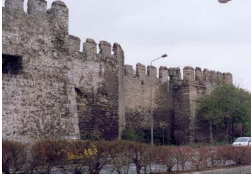
Resim 4.42. Sultanahmet bölgesinin en kuzeydeki surları M. Özçakı
