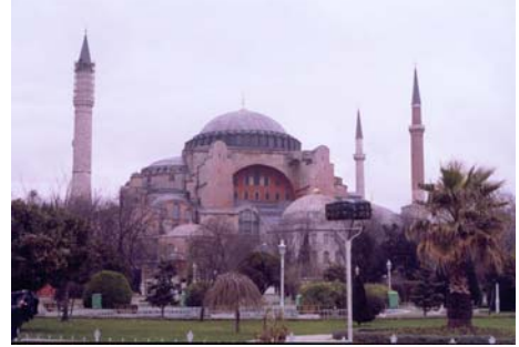
Resim 3.10. Ayasofya'nın güney cephesinin görünüşü M. Özçakı
