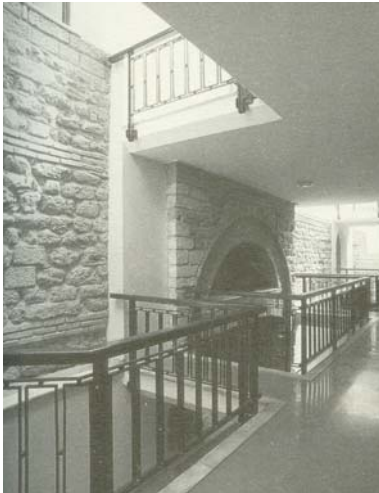
Şekil 1.2. İstanbul, Tahtakale Hamamı restorasyonunda çürütme tekniğinin uygulanması
