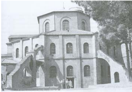
Resim 1.11. San Vitale Kilisesi'nin uçan payandaları Z. Ahunbay, Tarihi Çevre Koruma ve Restorasyon , 1999, 95
