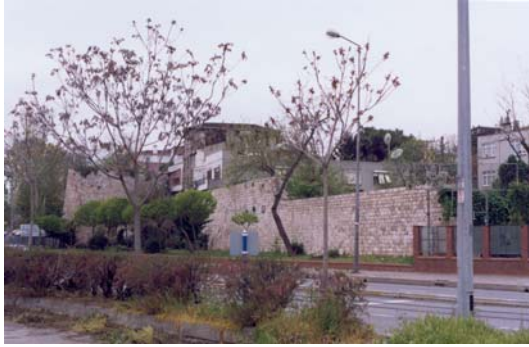
Resim 4.64. 30. ve 31. kuleler arasına yeni inşa edilen surlar M. Özçakı
