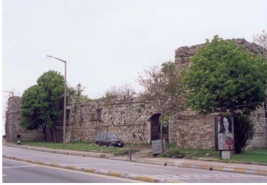
Resim 4.28. Değirmenkapı, 7.-8. kuleler ve surun kavis yaptığı noktadaki payanda M. Özçakı
