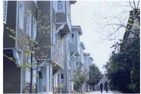
Resim 3.17. Soğukçeşme Sokağı'nın restorasyondan sonraki görünümü M. Özçakı
