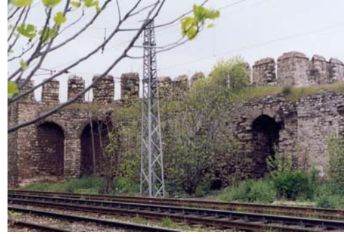
Resim 4.43. Surun kavis yaptığı köşedeki hafifletme kemerleri M. Özçakı
