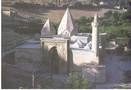
Resim 1.10. Divriği Ulu Cami minaresinin kesit genişletme yöntemiyle sağlamlaştırılması Z. Ahunbay, Tarihi Çevre Koruma ve Restorasyon , 1999, 92
