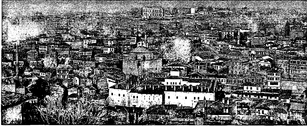
Şekil 3.27. Safranbolu Genel Görünüm, 2003. Fotoğraf: İ. Ö. Eren
