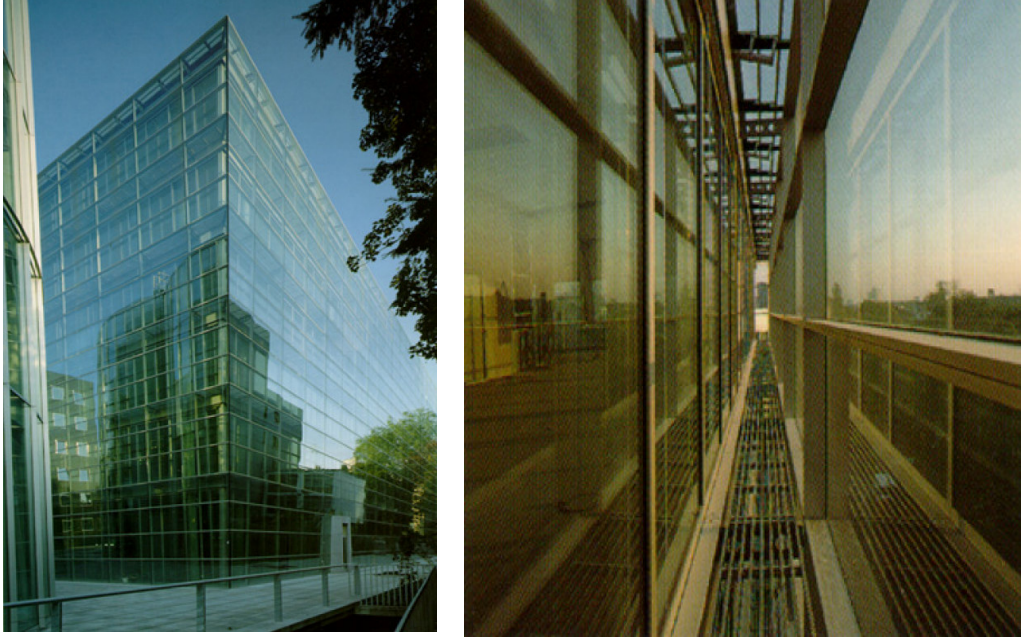
Şekil 3.28. İç ve dış kabukta güneş kontrol camları kullanılmış yapı örneği (Victoria Life Insurance Binası, Almanya) [Poirazis,H. 2004]
