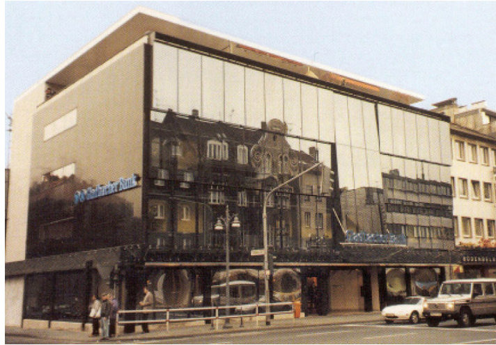
Şekil 4.15. Gladbacher Bank binası yenilenme sonrasındaki durumu [Poirazis,H. 2004]
