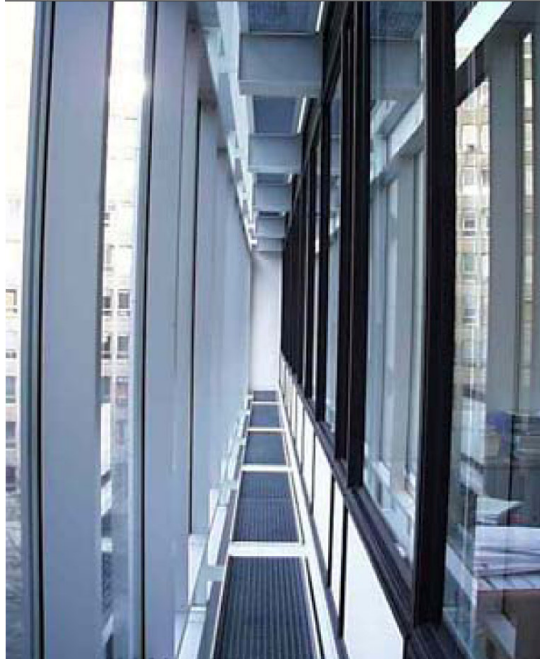
Şekil 3.42. Çok katlı bir çift kabuk cephenin ara boşluğundan görüntü
