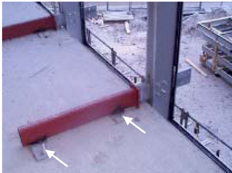
Şekil 3.2. Döşemeye üstten bindirilerek uzatılmış konsol taşıyıcıli strüktür örneđi [Uuttu, S. 2001]
