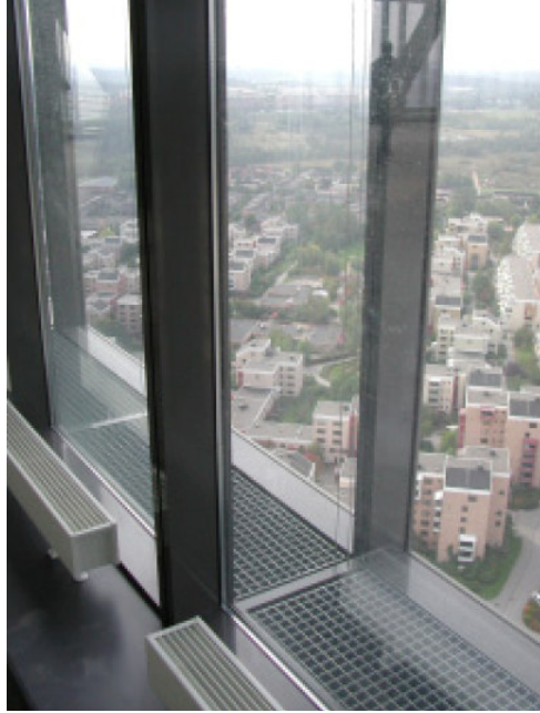
Şekil 3.9. Kista Tower binası çerçeve strüktürlü dış kabuğun detay görünüşü [Poirazis,H. 2004]
