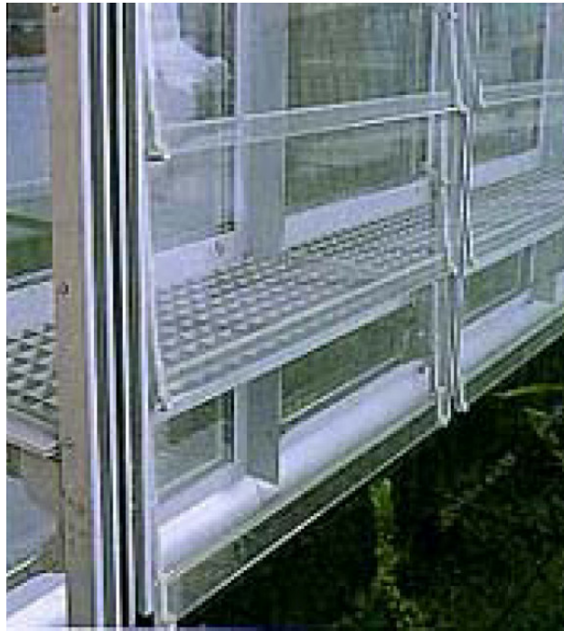
Şekil 3.37. Dış kabuğu cam panjurlardan oluşan yapı örneği (Debis Binası) [Poirazis,H. 2004]
