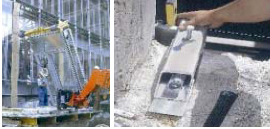
Şekil 2.18. Kutu tipi bir çift kabuk cephenin montaj görünüşü [Poirazis,H. 2004].
