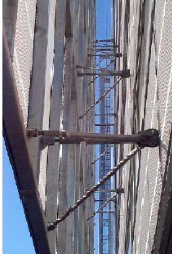
Şekil 3.7. Nokia Ruoholatti Binası asma strüktürlü dış kabuğun görünüşü [Uuttu,S. 2001]
