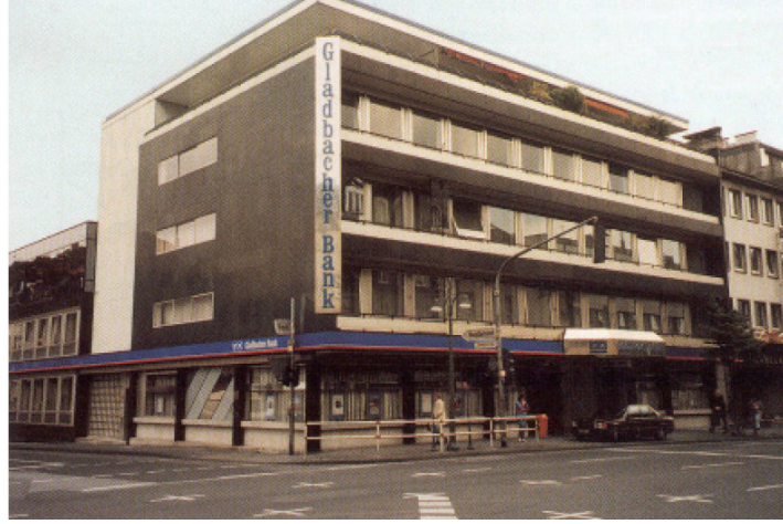
Şekil 4.14. Gladbacher Bank binası yenilenme öncesindeki durumu [Poirazis,H. 2004]
