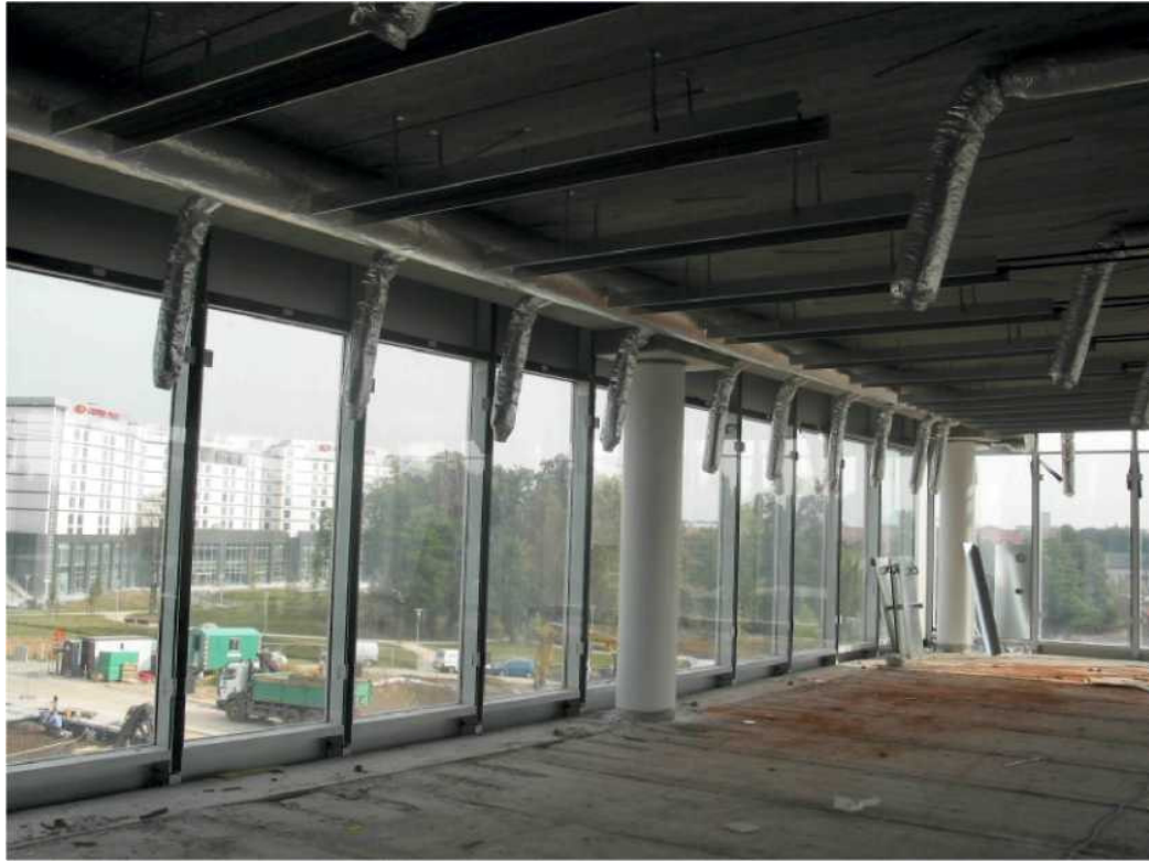
Şekil 2.22. Kutu tipi bir çift kabuk cephenin montaj halindeki görünümü [Loncour, X. 2004]
