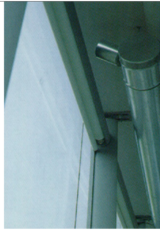
Şekil 3.39. Stor güneş kırıcılı bir yapının dışarıdan ve boşluk içinden görünüşü (HalenseestraBe Binası, Berlin) [Poirazis,H. 2004]
