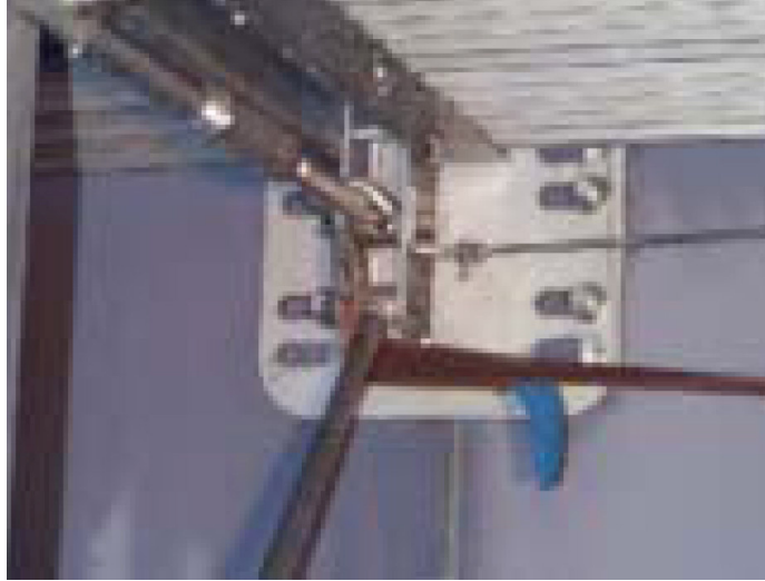
Şekil 3.5. Asma strüktürlü bir sistemin ana taşıyıcı sisteme bağlantı detay görünüşü [Uuttu,S. 2001]
