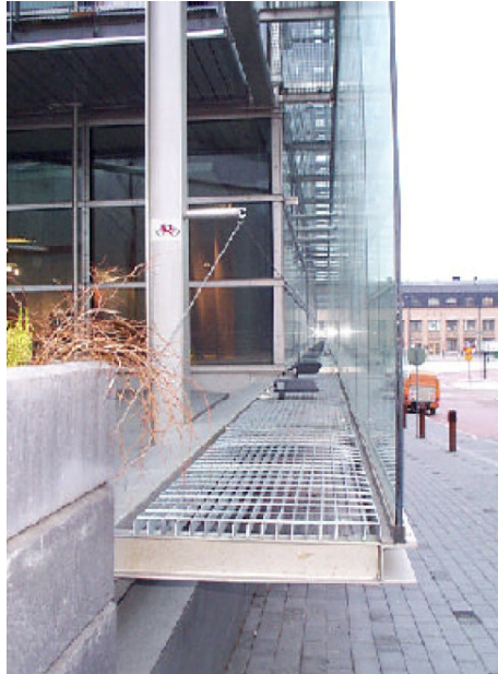
Şekil 3.27. Dış kabukta 4+6mm'lik temperli lamine cam kullanılmış yapı örneği (Sanomatalo Binası, Finlandiya) [Poirazis,H. 2004]
