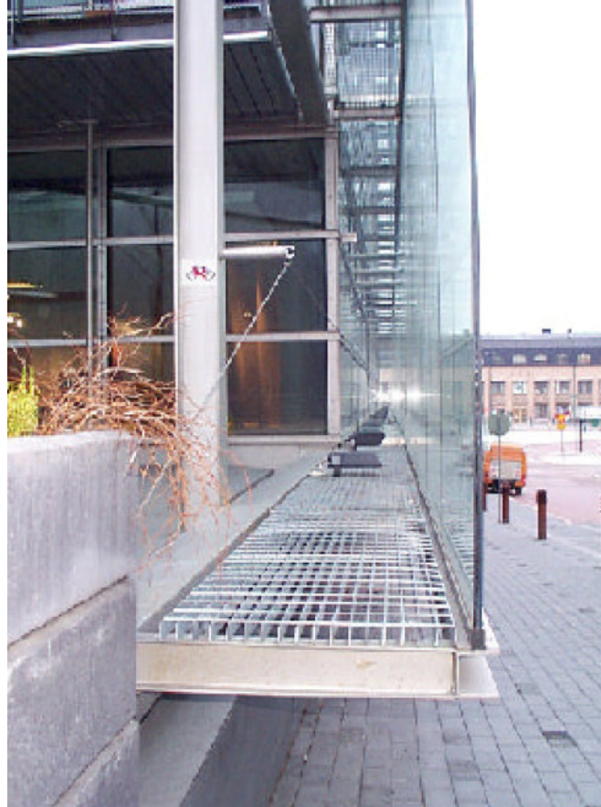
Şekil 3.3. Sanomatalo Binası (konsol taşıyıcılı strüktür örneği) [Uttu,S. 2001]
