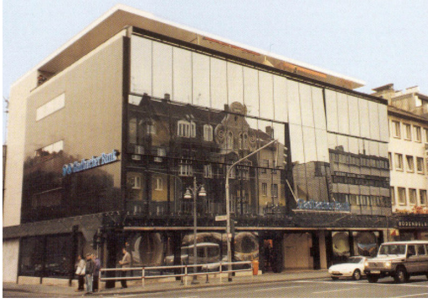
Şekil 3.29. Dış kabukta yansıtıcı güneş kontrollü cam kullanılan yapı örneği (Gladbacher Bank, Almanya) [Poirazis,H. 2004]
