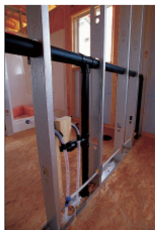
Şekil 2-74 Elektrik ve su tesisatının profiller arası boşlukta düzenlenmesi ve profillerde açılan deliklerden geçirilmesi. [43], [72, s.92]
