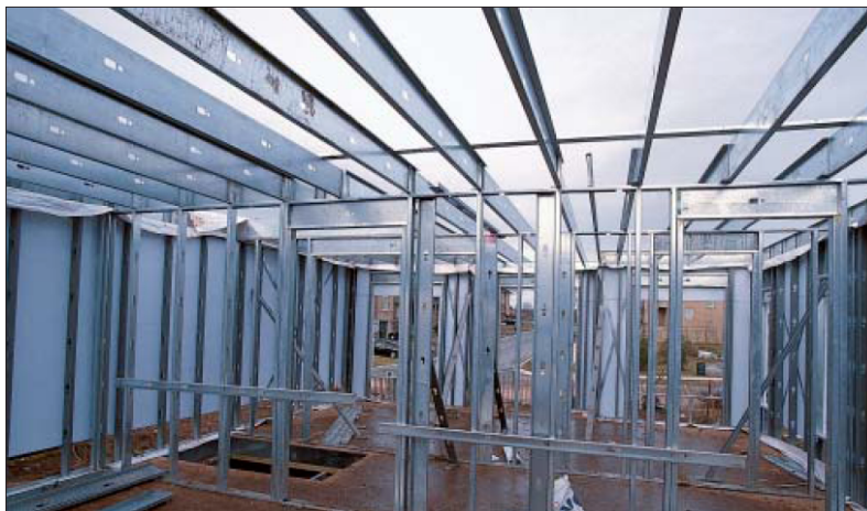
Şekil 2-77 Doğrusal elemanlı hafif çelik inşaatı. [42]
