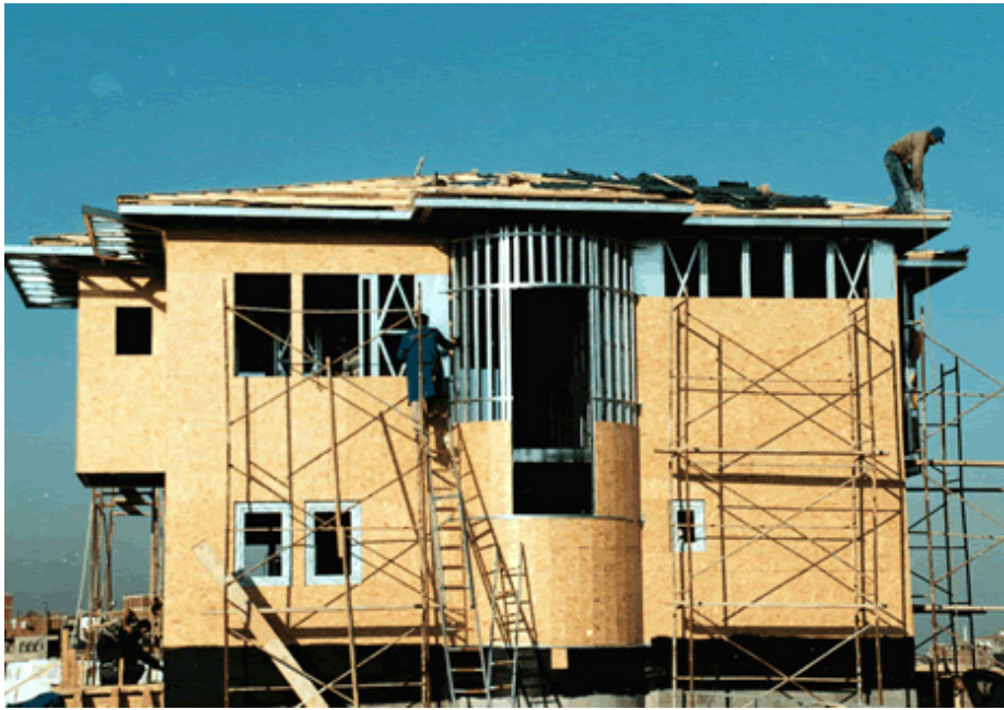
Şekil 3-95 Hafif çelik yapıda cephe kuruluşu, Aydos-Pendik'te konut. [143]
