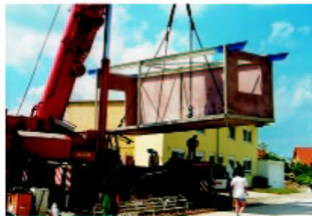
Şekil 2-91 Açık yüzleri sıcak hadde çelik profiller ile desteklenmiş hafif çelik hücreler.
