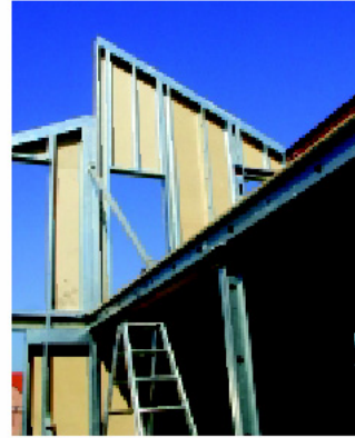
Şekil 2-84 Bir yüzeyi OSB kaplanmış pano yapım sistemi [103], [105]
