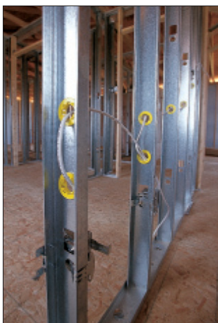
Şekil 2-74 Elektrik ve su tesisatının profiller arası boşlukta düzenlenmesi ve profillerde açılan deliklerden geçirilmesi. [43], [72, s.92]
