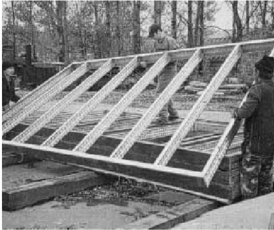
Şekil 2-82 Şantiyede hafif çelik prefabrike duvarın montajı [105]
