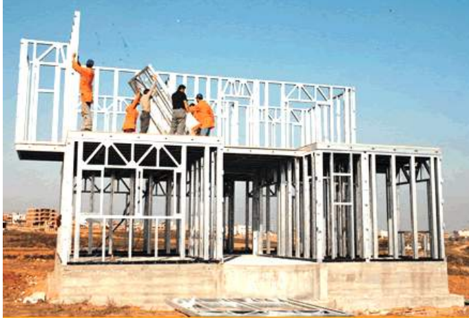
Şekil 2-81 Izgara pano yapı sistemi. [143]
