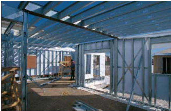
Şekil 2-79 Doğrusal elemanlı hafif çelik inşaatı [42]
