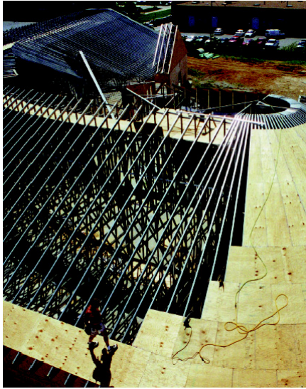
Şekil 2-67 Büyük açıklıklı hafif çelik makaslar ile eğrisel formların oluşturulması.[130]
