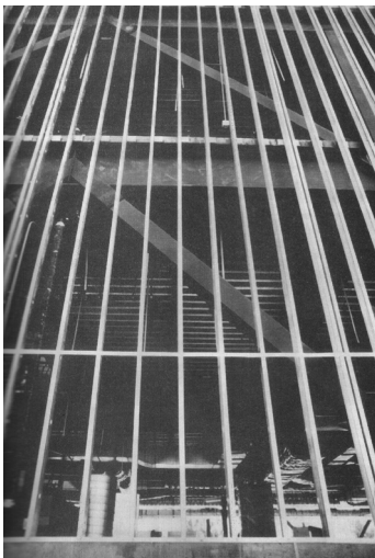
Şekil 1-10 Hafif çelik profillerin giydirme cephe kuruluşunda kullanımı. [12]
