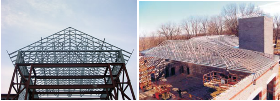
Şekil 2-66 (A) Kanada, Ottawa'da konvansiyonel çelik strüktürlü bir yapının çatısının, (B) A.B.D.'de betonarme strüktürlü bir yapının çatısının, büyük açıklık geçen hafif çelik makaslar ile oluşturulması. [138],[139]
