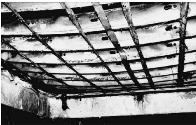
Şekil 3-38 Yangın etkisinde hafif çelik döşeme [10, s.3]
