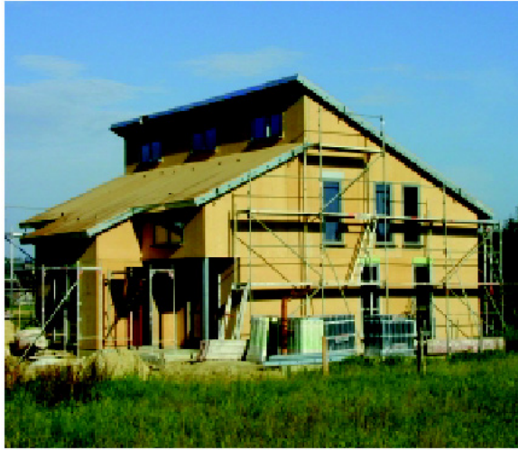
Şekil 2-84 Bir yüzeyi OSB kaplanmış pano yapım sistemi [103], [105]
