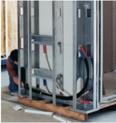
Şekil 2-73 Ön üretim esnasında, hafif çelik konstrüksiyon içine tesisatın montajı. [103]
