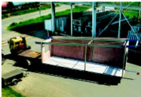
Şekil 2-91 Açık yüzleri sıcak hadde çelik profiller ile desteklenmiş hafif çelik hücreler.
