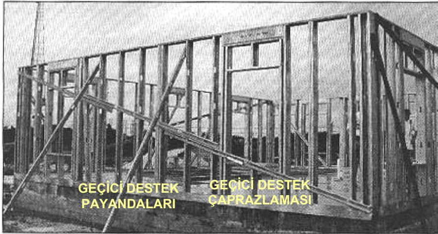
Şekil 2-86 Duvar montajının ardından yapılan geçici destek payandaları ve çaprazlama [84, s.21]
