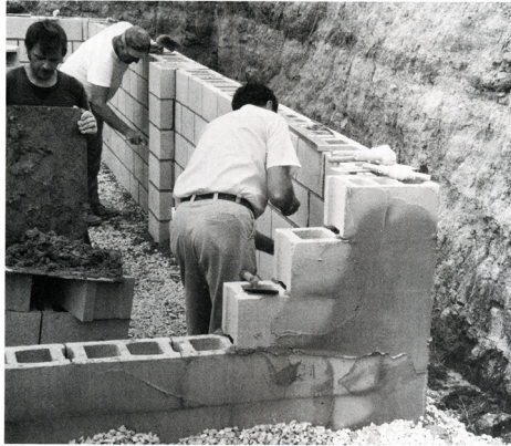
Şekil 2-29 (A) Bodrum temel duvarlarının beton bloklardan oluşturulması [12] (B) hafif çelik döşeme bağlantısı [25],[79],
