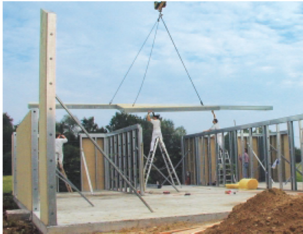
Şekil 2-85 Bitmiş döşeme elemanın şantiyede montajı [103, s.20]
