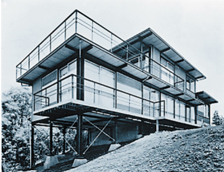
Şekil 2-35 Hafif çelik sistemlerin, münferit temellere oturan konvansiyonel çelik çerçeve ile kompozit strüktür oluşturması. [137]
