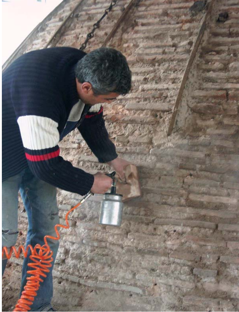
Foto 5.5. Feyzullah Efendi Medresesi restorasyonu-Kubbede enjeksiyon uygulaması görüntüsü-(AKALAY İNŞ. Arşivi)
