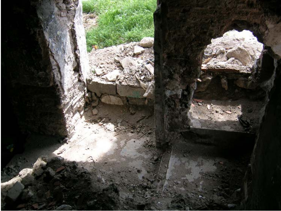
Foto C. 34 Dershanenin orjinal döşeme kotu (2005)
