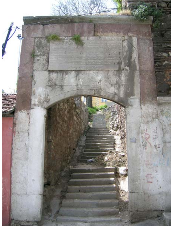
Foto C. 22- Külliye'nin giriři- Merdivenli geitle bir st kotta bulunan medrese blmne ıkılıyor.(2005)
