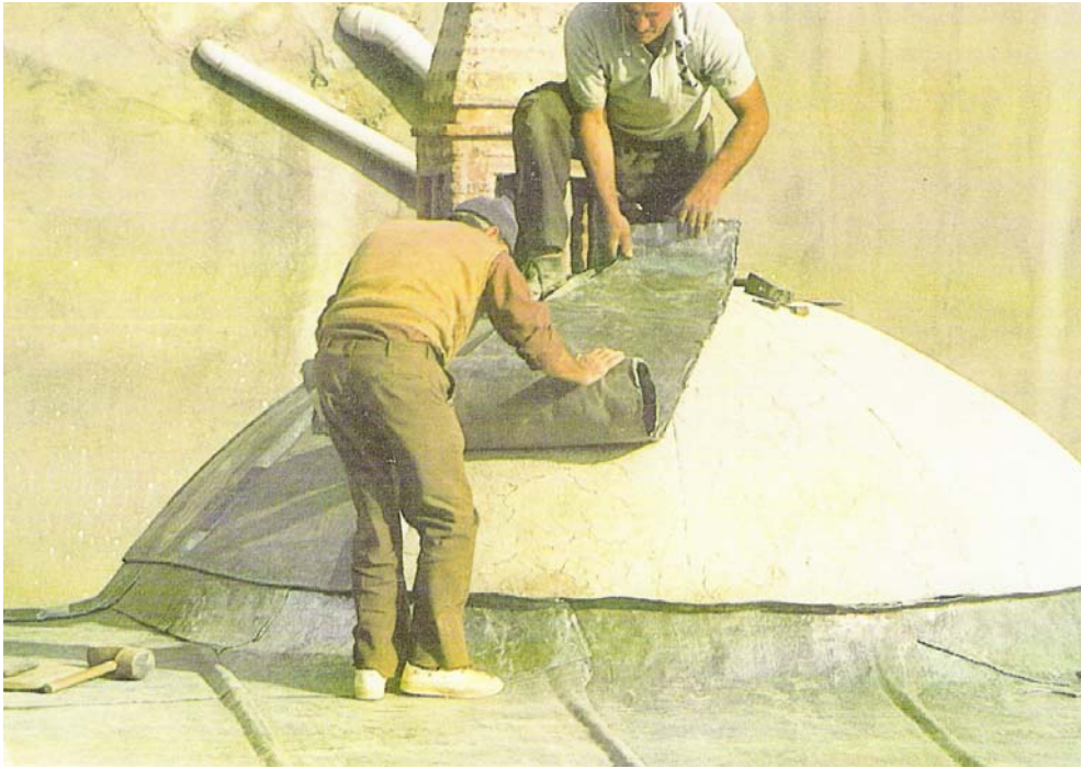
Foto 5.7. Cafer Ağa Medresesi restorasyonu-Kubbe kurşun örtülerinin kaplanması (Doğan Kuban ;“Cafer Ağa Medresesi Restorasyonu”)
