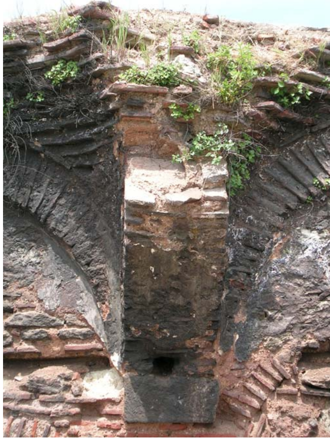
Foto C. 31- Yıkılan Revak kemerinin başlangıç izi (2004)
