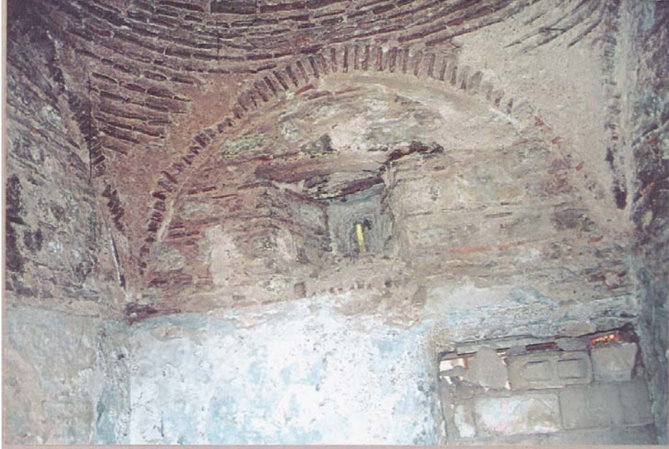
Foto C. 35- Kitaplık bölümü örtü sistemi (2004)
