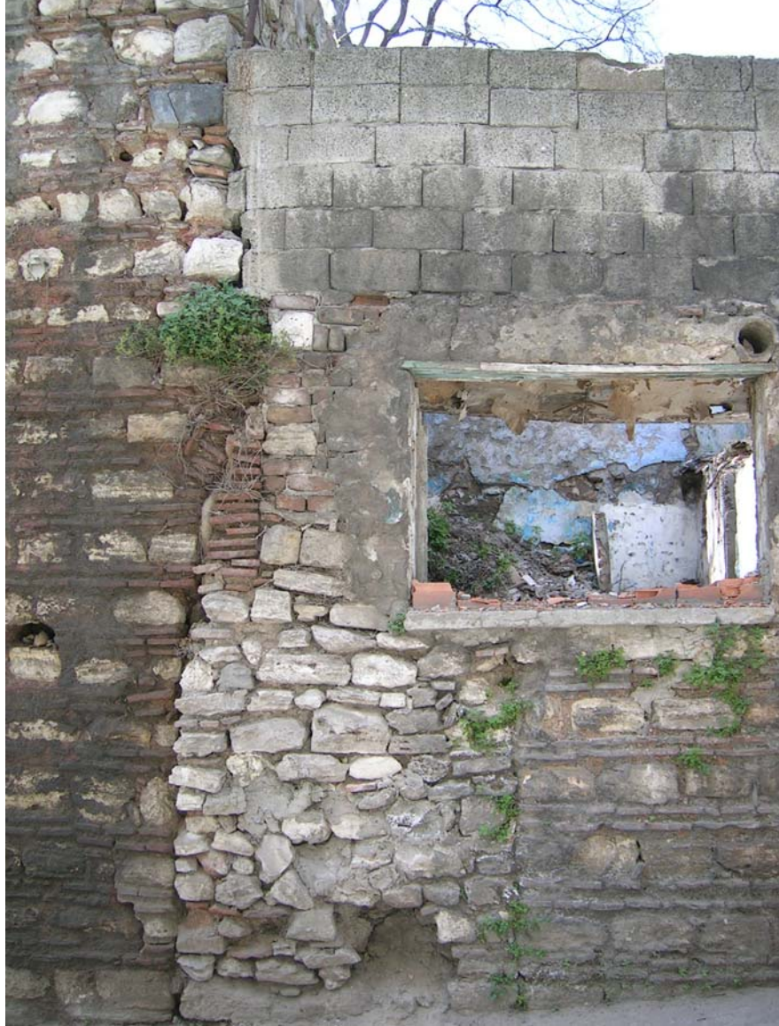
Foto C. 24- Sıbyan Mektebinin avlu girişinin kapatılan kapı boşluğu (2005)
