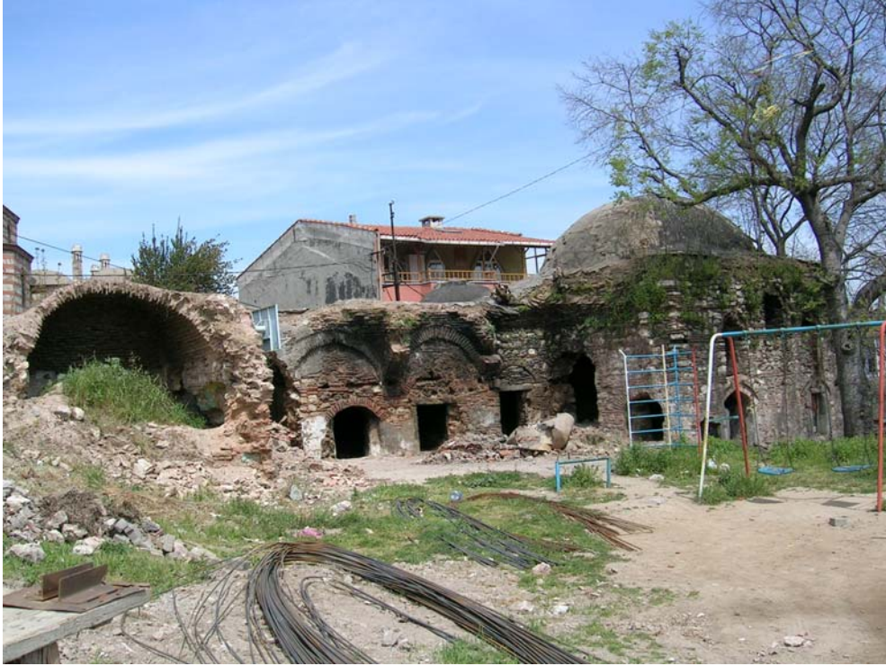
Foto C. 25- Medrese bölümünün yıkılan batı kanadı ve avludan görünüşü (2005)
