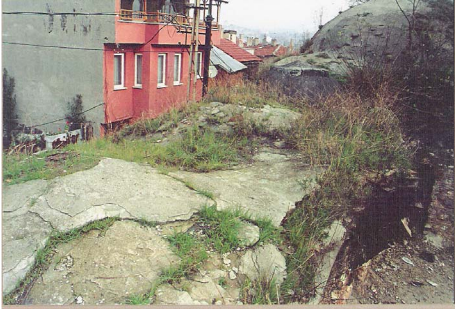
Foto C. 39- Medrese hücrelerinin örtü sistemleri üzerinde çimento sıva (2004)
