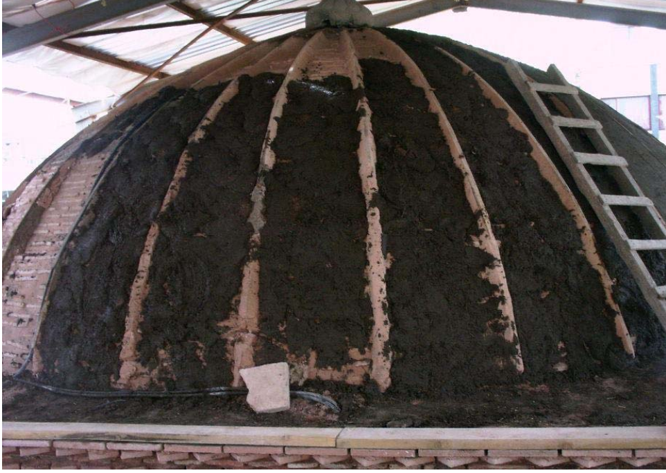
Foto 5.3. Feyzullah Efendi Medresesi restorasyonu-Kubbelerin kurşun altı çamur sıva uygulaması,saçaklarda ahşap hatil çakılması,kirpi saçak uygulaması (Ak-Alay İnş. Arşivi)
