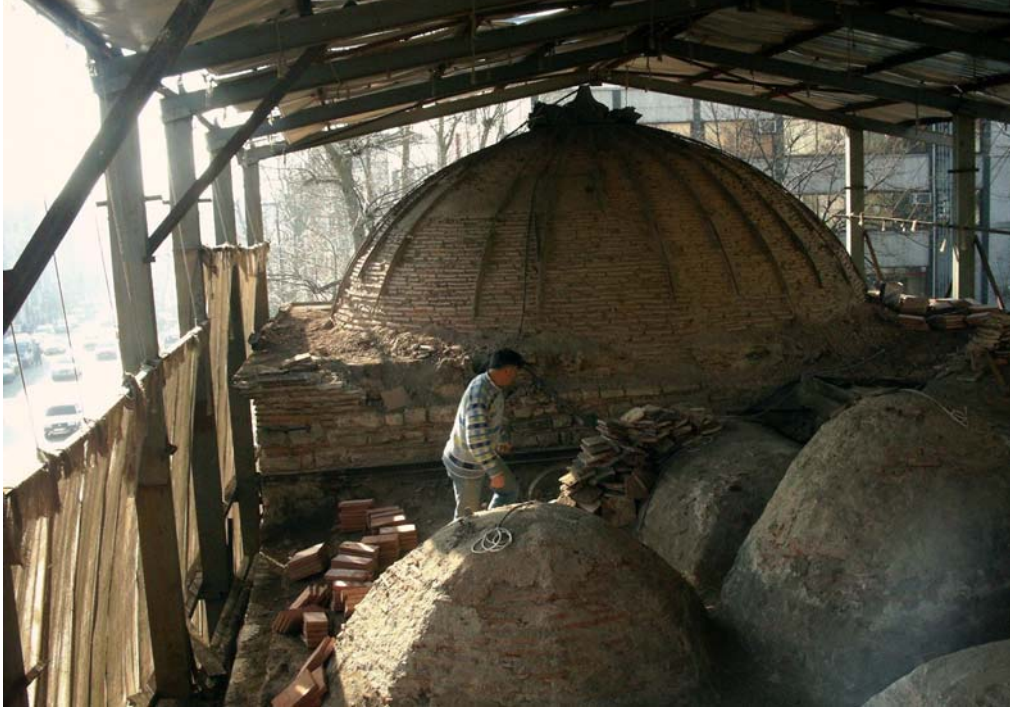
Foto 5.1. Fezullah Efendi Medresesi restorasyonu-Kubbelerin kurşun örtülerinin kaplanması öncesi hazırlık aşaması ve yapının üzerinin geçici çatı ile kapatılması (Ak-Alay İnş. Arşivi) 51
