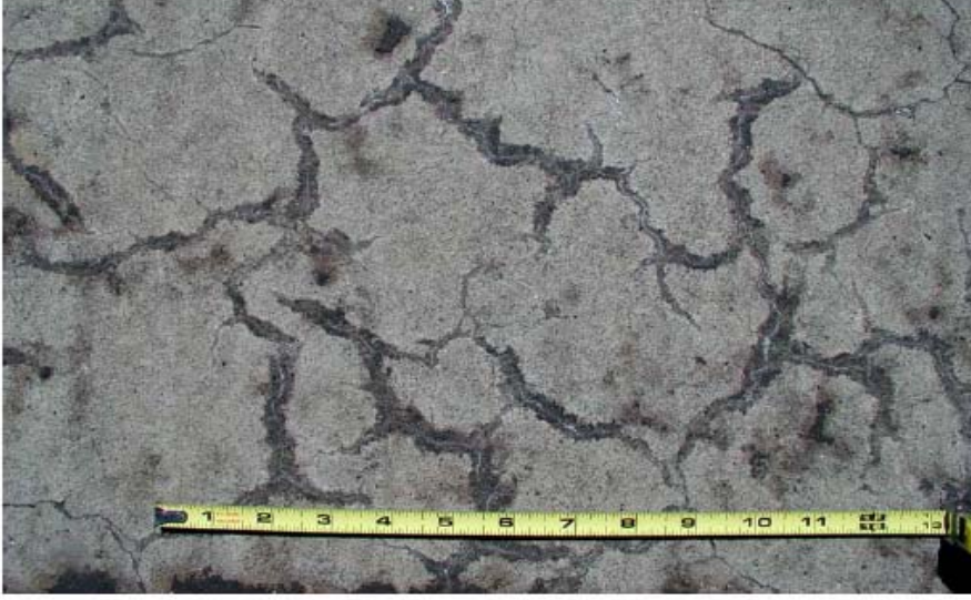
Resim 2.6: Çatlaklardan jel sızması 29
