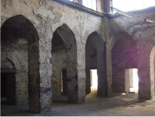
Resim 3.4 Gökdere Medresesi'nin avlusundan revaklarının görünüşü. (Nisan 2005)
