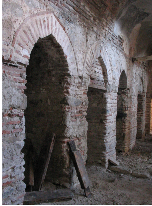
Resim 3.9 Gökdere Medresesi'nin hücre kapıları. (Nisan 2005)
