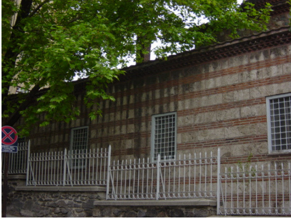
Resim 2.6 Lala Şahin Paşa Medresesi'nin doğu cephesi.
