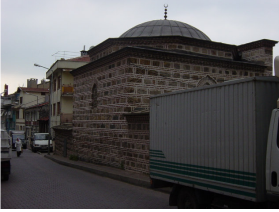
Resim 2.45 Şair Ahmet Paşa Medresesi'nin Güney cephesi.
