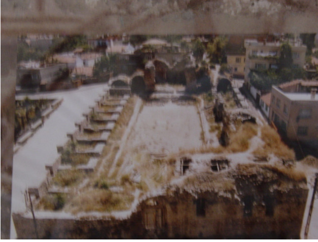
Resim 2.22 Yıldırım Darüşşifasının onarım geçirmeden önceki durumu.
