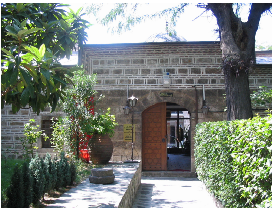
Resim 2.48.Şair Ahmet Paşa Medresesi'nin giriş cephesi.
