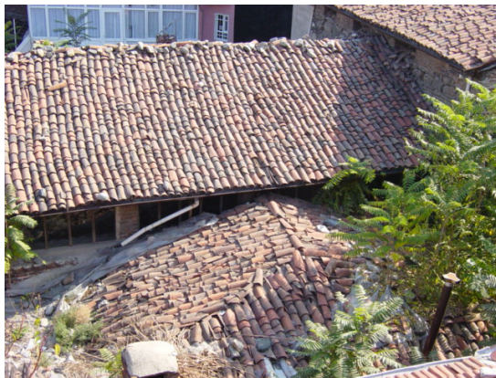
Resim 3.16 Gökdere Medresesi'nin çatısı. (Nisan 2005)
