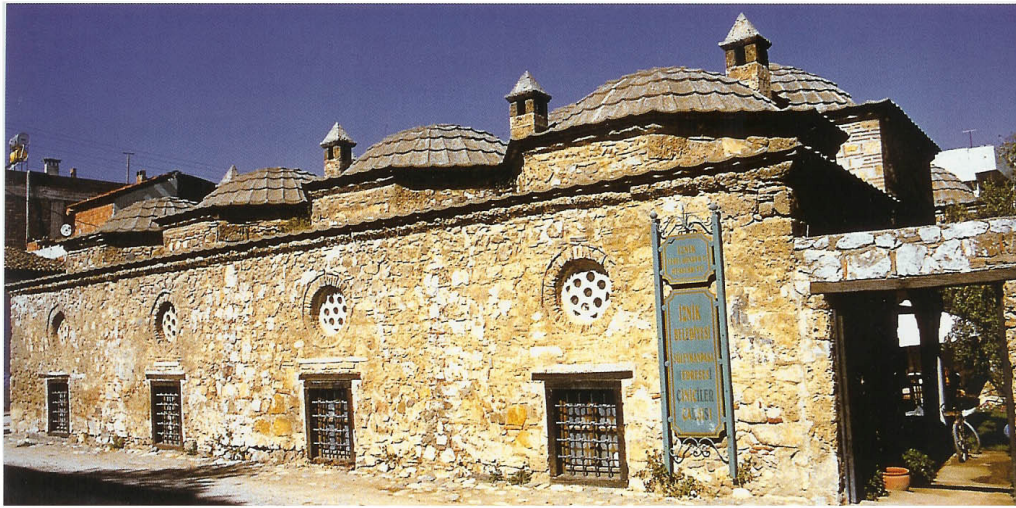
Resim 2.1. Süleyman Paşa Medresesi’nin günümüzdeki durumu
