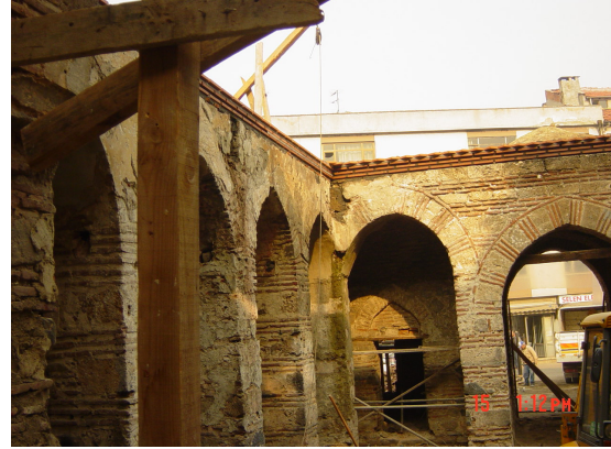
Resim 3.5 Gökdere Medresesi'nin avlusundan revaklarının görünüşü. (Şubat 2006)
