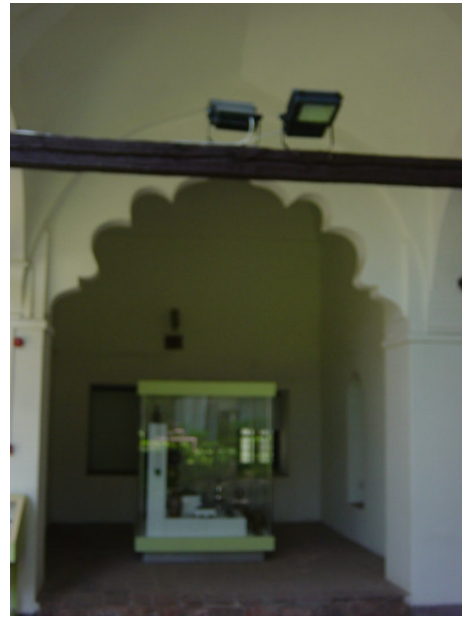
Resim 2.38 Yeşil Medresesi'nin doğu tarafında bulunan yan eyvanın girişi.
