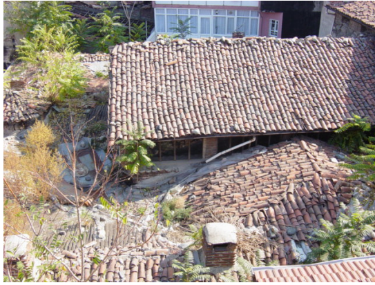
Resim 3.12 Gökdere Medresesi'nin çatısı. (Nisan 2005)
