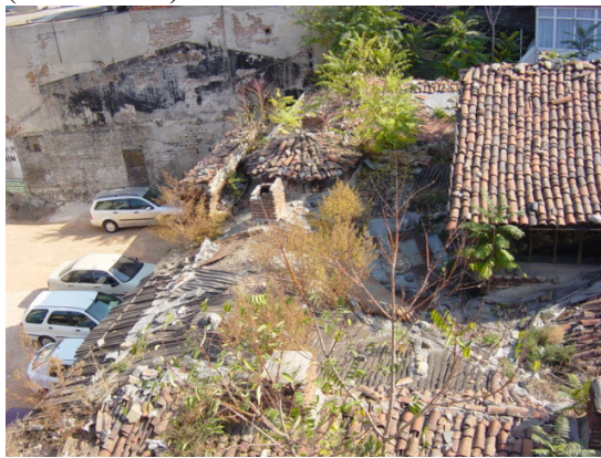
Resim 3.14 Gökdere Medresesi'nin çatısı. (Nisan 2005)
