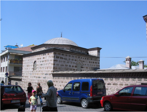
Resim 2.47 Şair Ahmet Paşa Medresesi'nin Güney cephesi.
