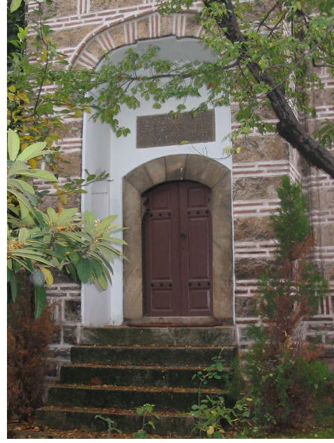
Resim 2.46 Şair Ahmet Paşa Medresesi'nin Giriş kapısı.
