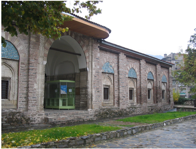
Resim 2.32 Yeşil Medresesi'nin giriş cephesi.
