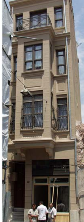
AFTER RESTORATION / RESTORASYONDAN SONRA
