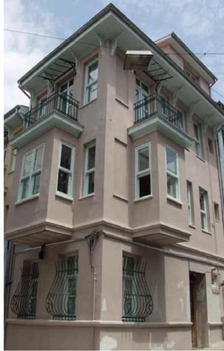
AFTER RESTORATION / RESTORASYONDAN SONRA
