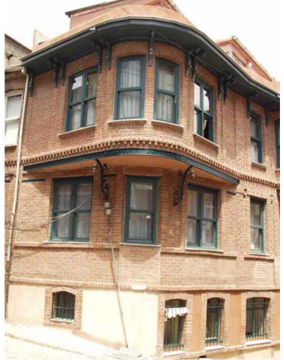
AFTER RESTORATION / RESTORASYONDAN SONRA
