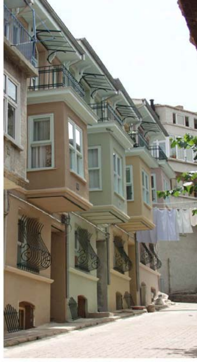
AFTER RESTORATION / RESTORASYONDAN SONRA
