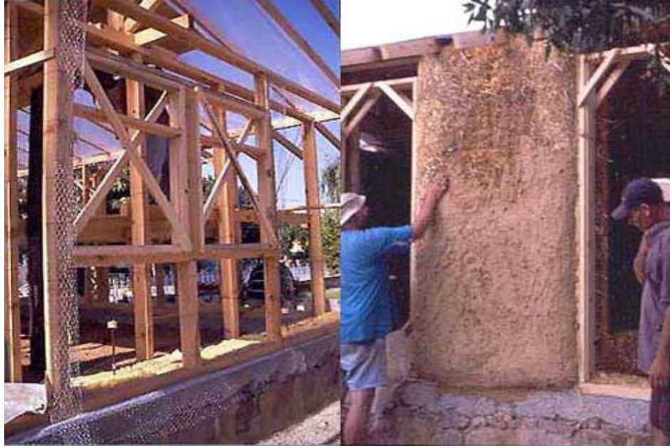
Resim 3.37. 85 Ahşap konstrüksiyonlu kerpiç ev yapımı
