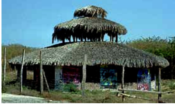
Resim 1.1. 6 iklim koşullarına elverişli yoğun güneş ışığından koruma amaçlı doğal havalandırmalı geleneksel çatı örtüsü
