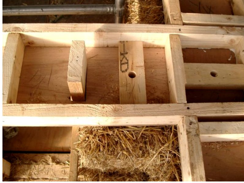
Resim 3.40. 88 Geçme sistemi ile birleştirme ve vidalama ile sabitleme
