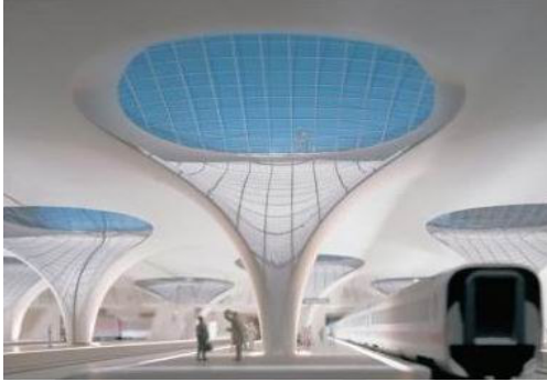
Resim 1.6. 16 Stuttgart Tren İstasyonu taşıyıcı sistem ve gn ıřığı aydınlatma sistemi beraber zlerek mimariye katılmıř - tavan dzlemi dolařım alanı
