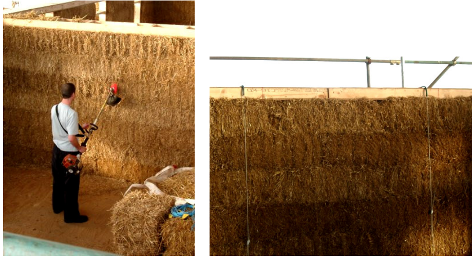
Resim 3.41. 89 Sıvama işlemine duvarı hazırlamak için düzleme ve çelik halatla sabitleme
