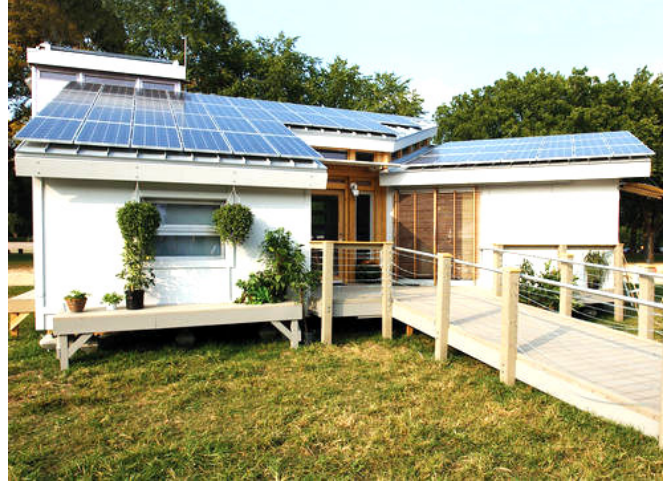
Resim 2.13. 30 çatı kapaması yapıldıktan sonra tüm yüzeyin enerji panelleri ile kaplanması
