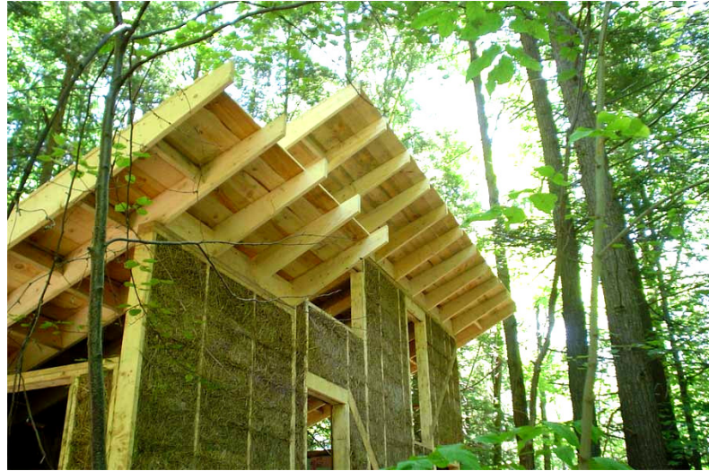
Resim 1.4.2. 11 dış cephede saman balyası ile duvar örümü
