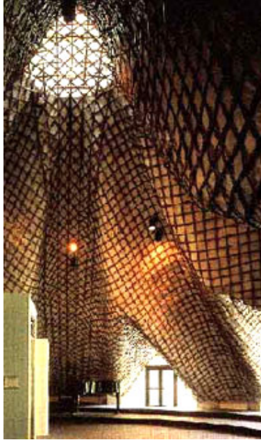
Resim 3.23. 67 Kafes-yığma sistem çatı ile yirmi metre yüksekliğe ulaşılmıştır
