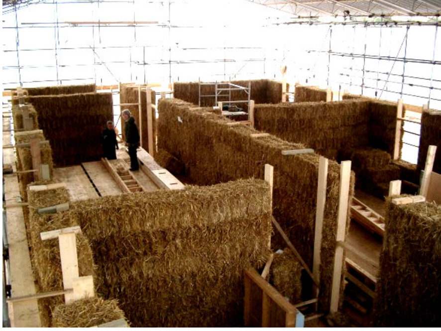
Resim 3.38. 86 Saman balyasından duvar örümü
