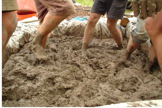
Resim 3.21. 64 Kerpiç sıva harcı karma yöntemi
