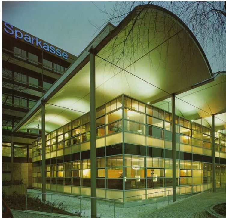
Fotoğraf 3.06: Saydam Kompozit, ısı soğuran füme cam ve low-e kaplı camların bir arada kullanımı. Savings Bankası Kiel, Almanya. [32]
