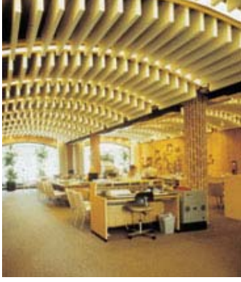
Resim 3-19: Ofislerde kullanılan mekan yutucuları
