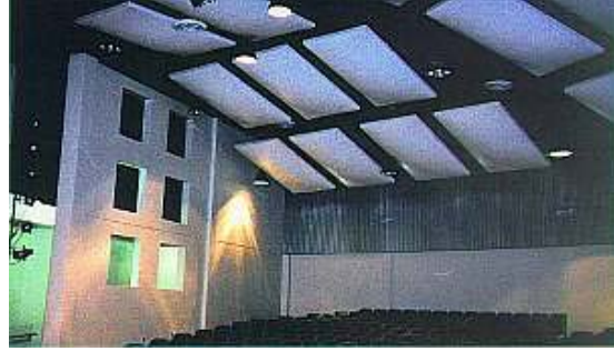
Şekil 3-28 : Cam lifi içerikli kompozit sistem ile tek düzlemde yansıtma yapabilen levhalar (birimler)
