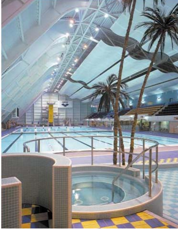
Resim 3-32: Akustik yutucu panellerin spor salonlarında kullanımı, Manchester Aquatic Center ana havuzu, Mimar: Gordon Mungall, 2000, İngiltere
