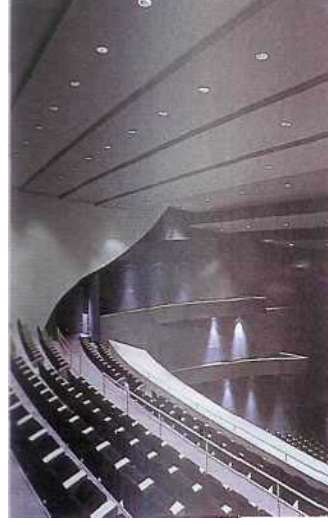
Resim 3-13: Delikli metal saç cilalı panolar Mimar: Equinoxe, Chateauroux. Akustik proje: G. Noël, Akustik Proje
