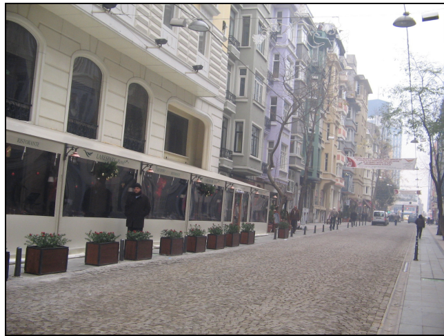
Fotoğraf 22. Cephe düzenlemesinden bir görünüm
