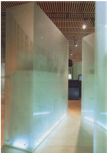
Resim 65 Mekanda asitli cam uygulaması.[66,s.38]
