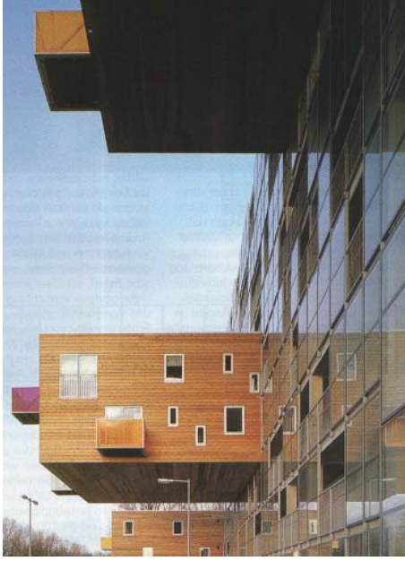
Resim 64 Bina cephesinde renkli ve renksiz cam uygulaması. [53,s.37]
