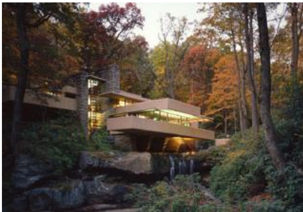
Resim 32 [89] Falling Water (Şelale Evi). Mimar: Frank Lloyd Wright
