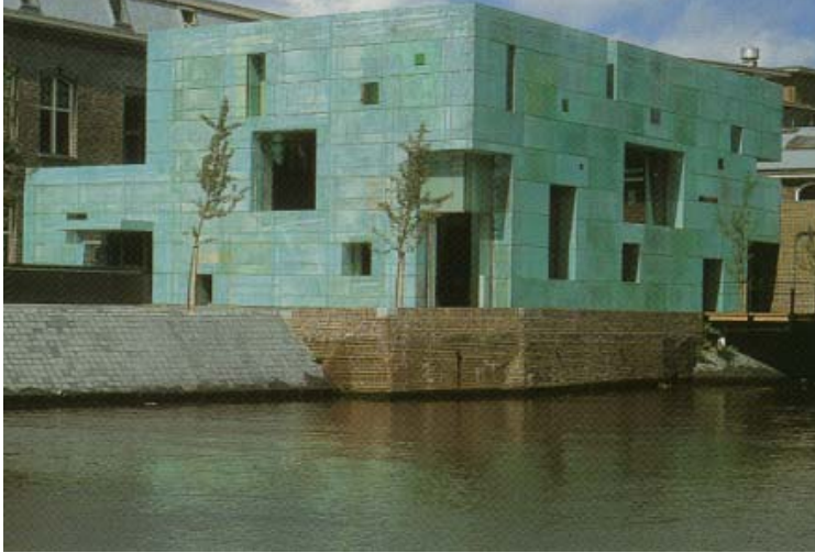
Resim 70 [64,s.16] Dış cephe yüzeyinde bakır panel kaplama.
