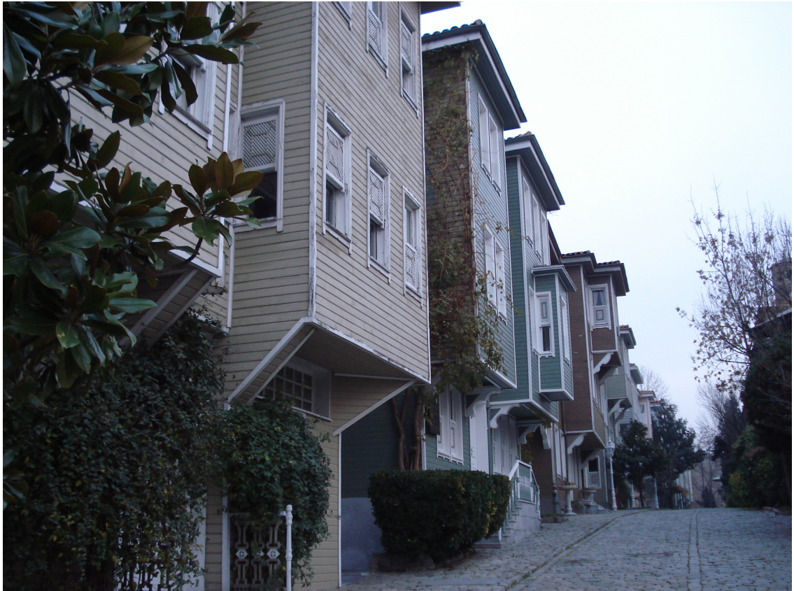
Resim 4.7. Tarihi Mekan Örneği; Sultan Ahmed'te Sofuk Çeşme Sokağı 233
