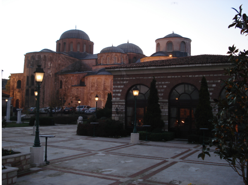
Resim 4.42. Zeyrekhane Restoran ve Pantokrator Kilise-Camii Görünümü 281
