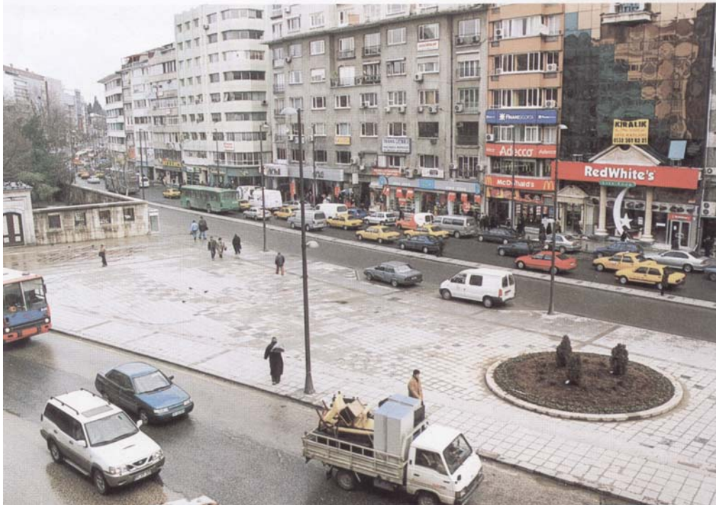
Şekil 4.8. Şişli Camii Önü Düzenleme Sonrası Görünüş
