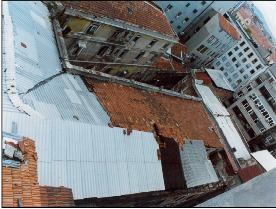
Resim 3.22 Pasajın çatı malzemesi
