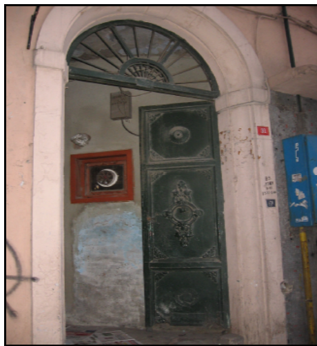
Resim 3.10 A Blok 2.Kısım giriş kapısı
