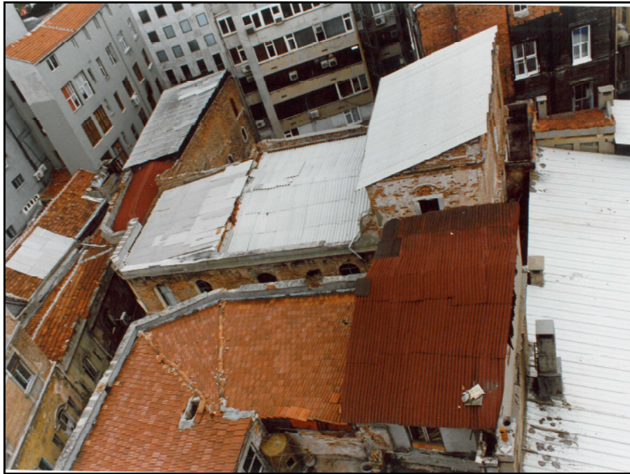
Resim 3.23 Pasajın çatı malzemesi
