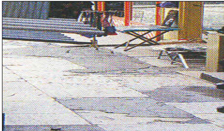
Resim 3.25 Avlu ii zemin döşeme kaplaması:
