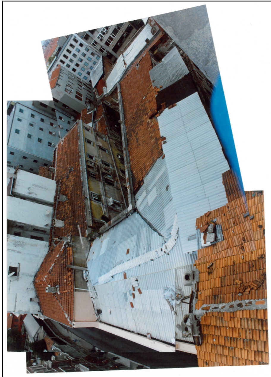
Resim 3.21 Pasajın çatı malzemesi
