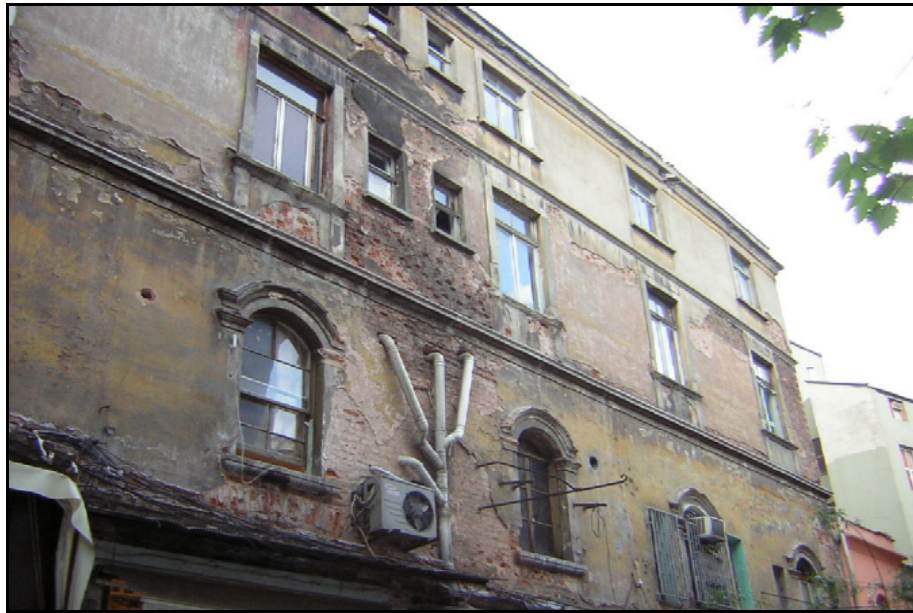
Resim 3.13 Pasajda bozulmaya uğramış pencereler
