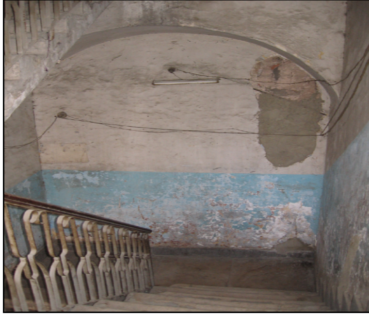
Resim 3.14 A Blok 2.kısım çıkış merdiveni
