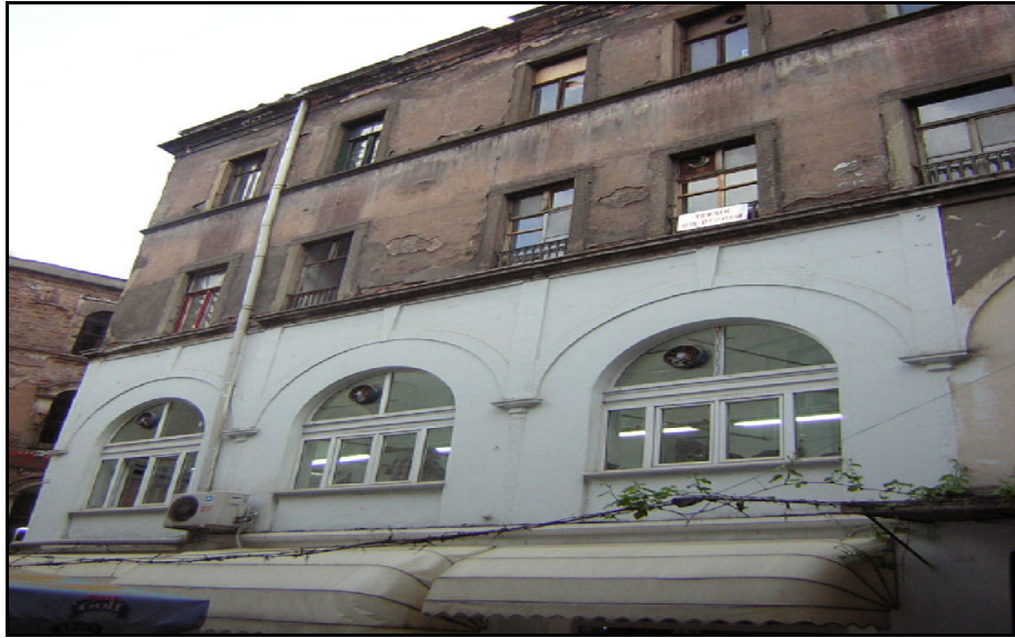
Resim 3.12 Pasajda bozulmaya uğramış pencereler
