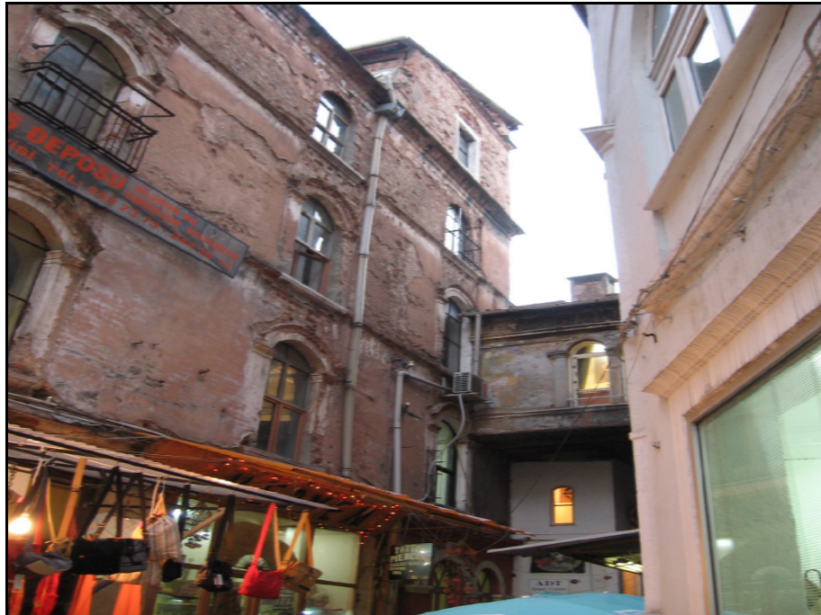
Resim 2.22 B Bloğun Kilise giriş avlusuna bakan cephesi.
