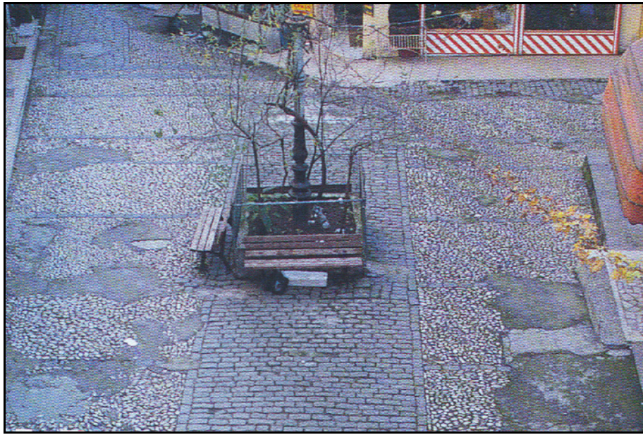
Resim 3.24 Avlu ii zemin döşeme kaplaması:
