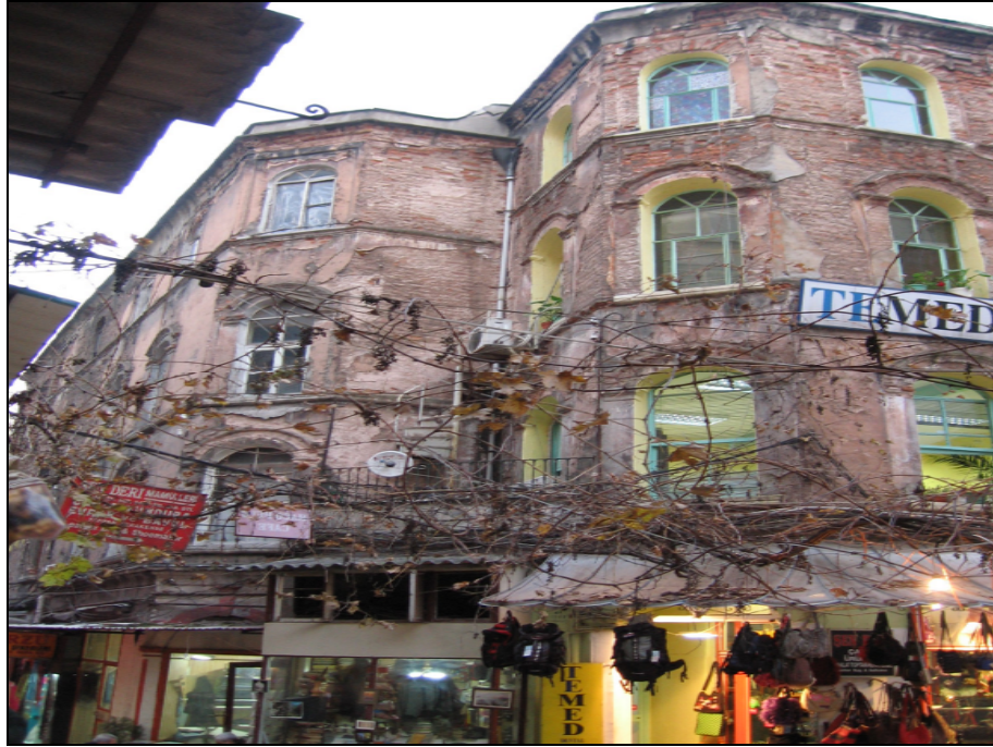
Resim 2.18 B Bloğun iç avludan görünüşü
