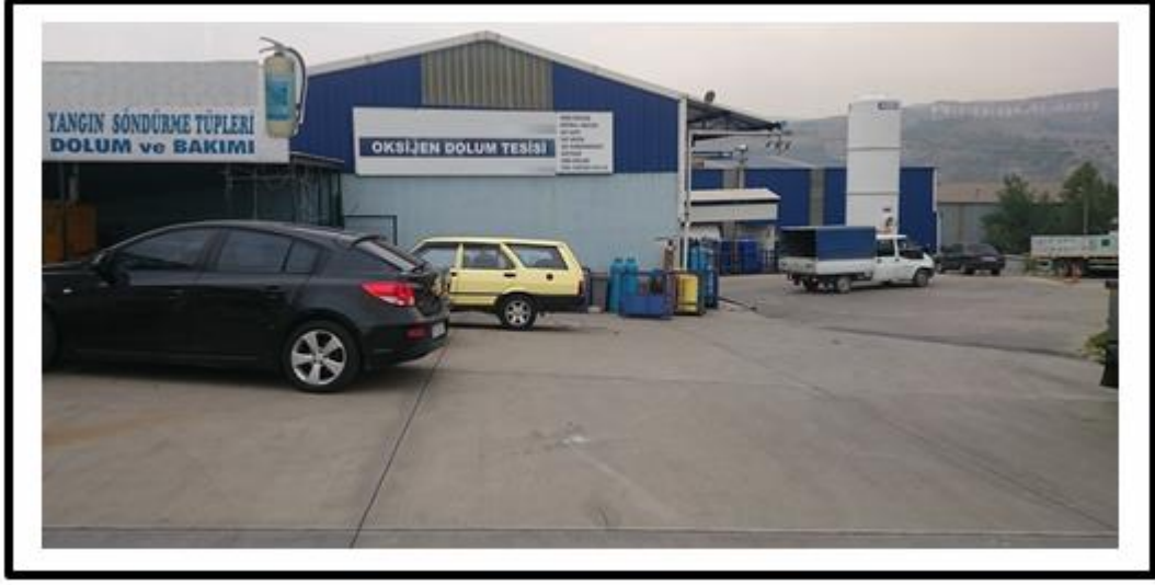
Şekil 111. Tesisin Dıştan Görünüşü
