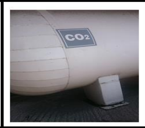
Şekil 122. Karbondioksit Tankı
