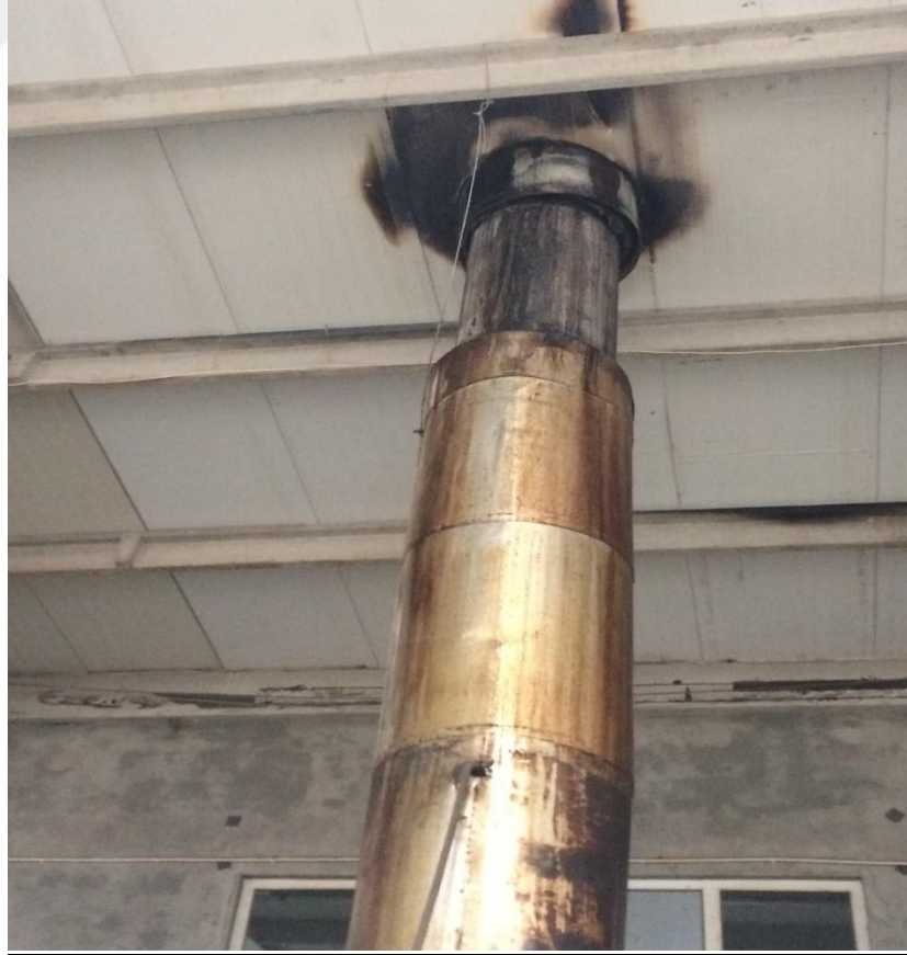
Şekil 23: Ram makinesi yanma olayı
