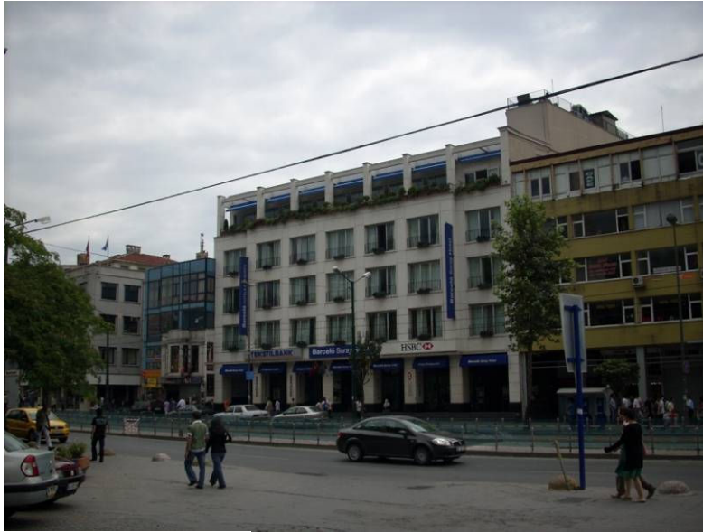
Fotoğraf 4.17: yapının ön cephesi.
