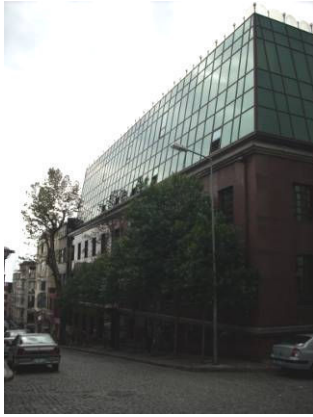
Fotoğraf 4.18: yapının Tiyatro Caddesi cephesi.
