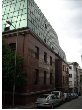
Fotoğraf 4.19: yapının ara sokak cephesi.
