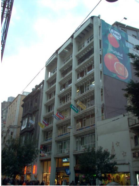
Fotoğraf 4.16: yapının ön cephesi.
