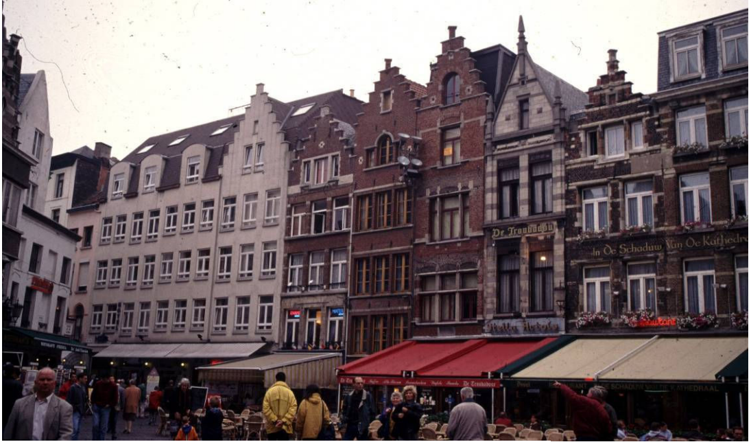
Fotoğraf 4.2: tarihi doku içindeki beyaz sıvalı yeni yapı, çevresiyle genel görünüş.
