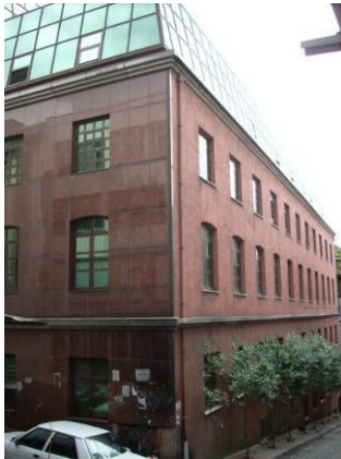
Fotoğraf 4.20: yapının arka cephesi.
