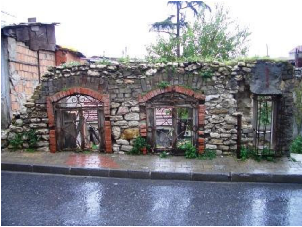
Foto C.3. 17 Selamlık zemin kat duvarı
