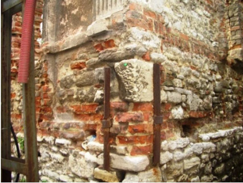
Foto C.3. 26 Türbe duvarı dış köşe-Detay
