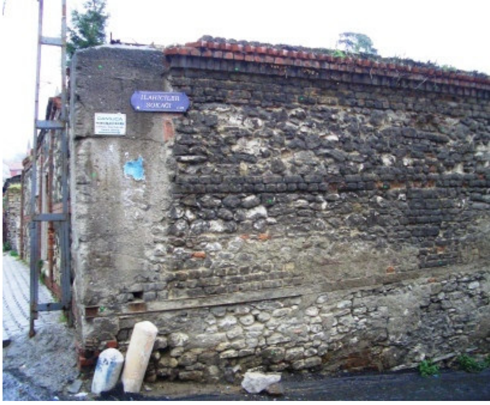
Foto C.3. 15 Tevhidhane Güneybatı Köşesi
