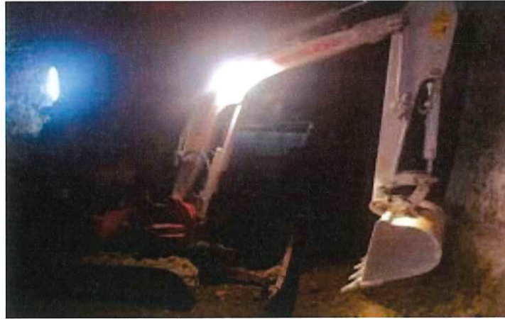
Şekil 6.6: Risk Değerlendirmesinin yapıldığı ekskavatör
