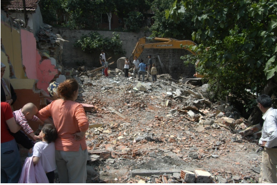
Şekil 15: Sarıgöl mahallesinde gecekondun yıkımı
