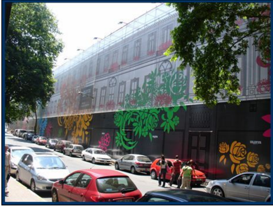
Resim 3.5. Akaretler'in Günümüzdeki Durumu (Proje Yapım Aşaması)
