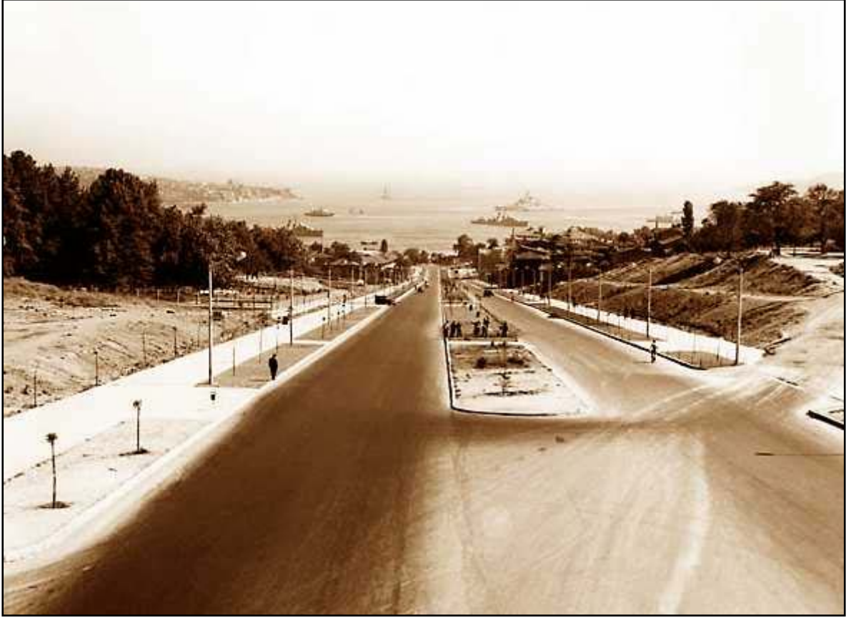
Resim 3.3. Barbaros Bulvarı Yapım Aşaması
