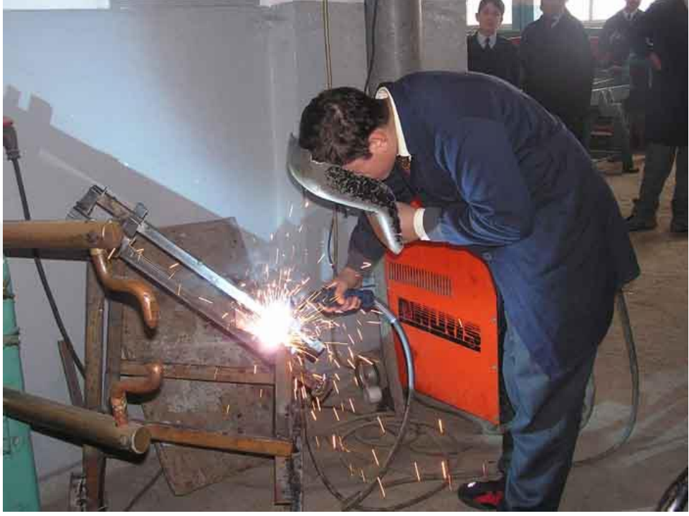
Şekil 10: Elektrik Ark Kaynağı
