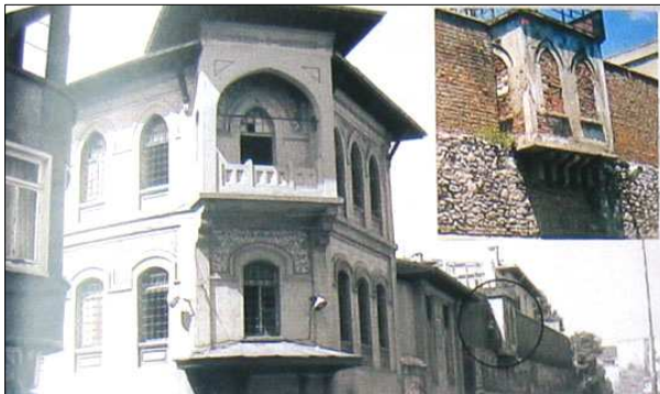
Resim 6.3: Gözetleme Kulesi'nin pencere ve kapıları örülerek kullanım dışı tutulmuş (Kaynak: “Cezaevi’nden Otel’e”, Yapı Dergisi, s.95)
