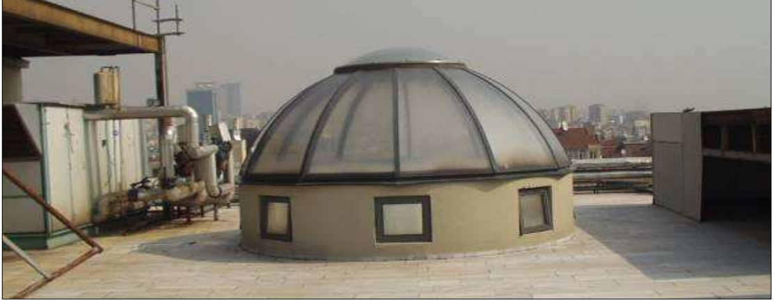
Resim 6.52: Mevcuttaki atriyumun şeffaf örtüsü (Kaynak: Metex Design Group fotoğraf arşivi)
