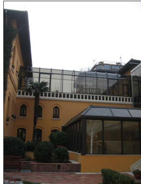
Resim 5.21: Bloklar arası yatay geçişi sağlayan tüp geçit (Kaynak: Banu Apaydın Başa-2006)
