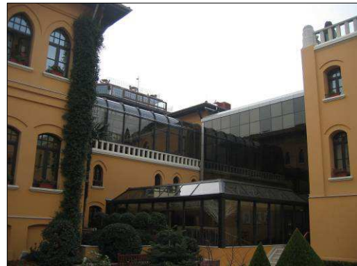
Resim 6.18: Orijinal yapıya yapılan cam ve çelik konstrüksiyon ekler (Kaynak: Banu Apaydın Başa–2006)
