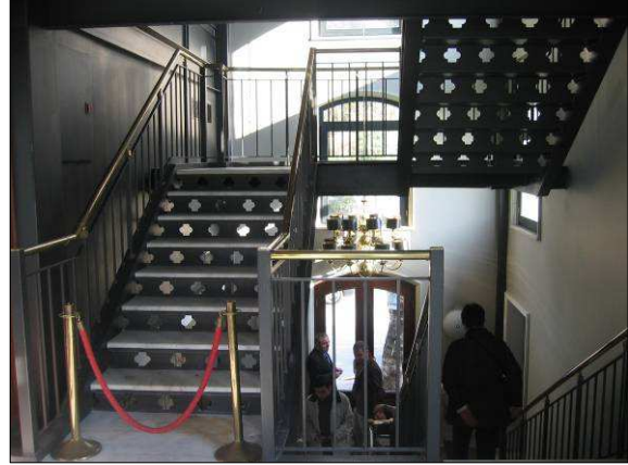
Resim 6.43: Çelik konstrüksiyonda yapılmış merdiven (Kaynak: Banu Apaydın Başa–2006)
