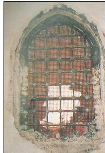
Resim 6.4: Bazı pencere ve kapı boşluklarının tümü ya da bir bölümü kapatılmış (Kaynak: “Cezaevi’nden Otel’e”, Yapı Dergisi, s.93)
