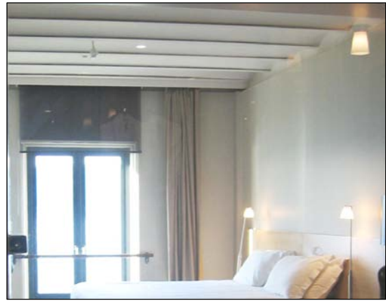
Resim 5.17: Sumahan Otel-volta döşemeli oda (Kaynak: Banu Apaydın Başa-2006)
