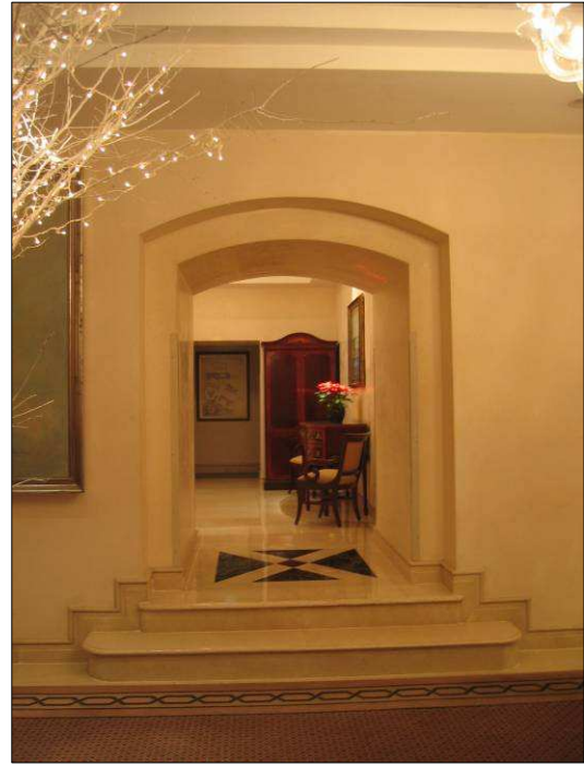
Resim 6.22: Bağlantı noktalarında kot farklarının kaldırmak için yapılan merdivenler (Kaynak: Banu Apaydın Başa–2006)
