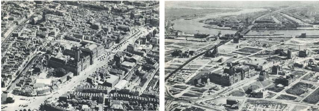
Şekil 4.1. Rotterdam'ın Alman bombardımanından önceki ve sonraki hali Stichting Hoogbouw
