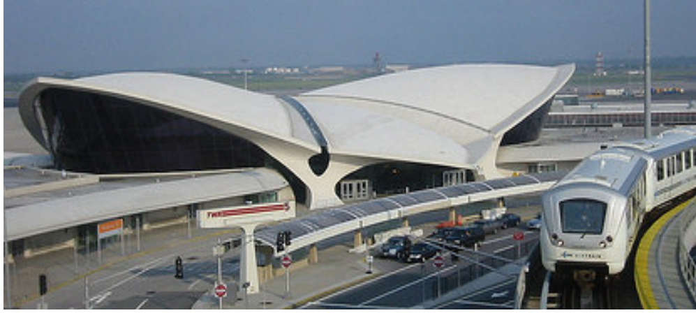
Şekil 3.92. TWA Terminal Binası, John F. Kennedy Havaalanı, Eero Saarinen, 1962.
