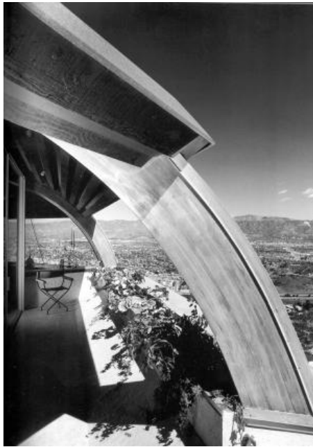
Şekil. 4.36. Malin House, teras.
