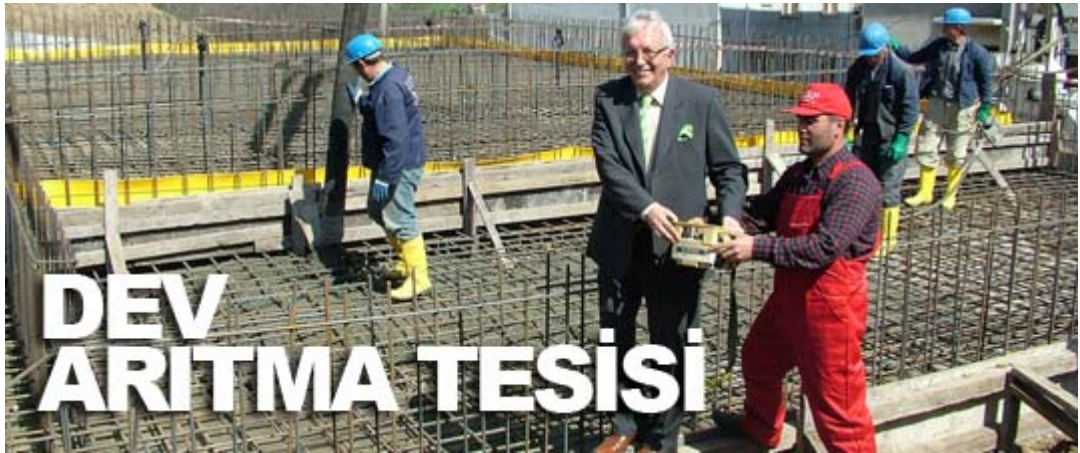
Şekil 4.17. Kdz.Ereğli Belediyesi İnternet Sayfası Arıtma Tesisi Görüntüleri
