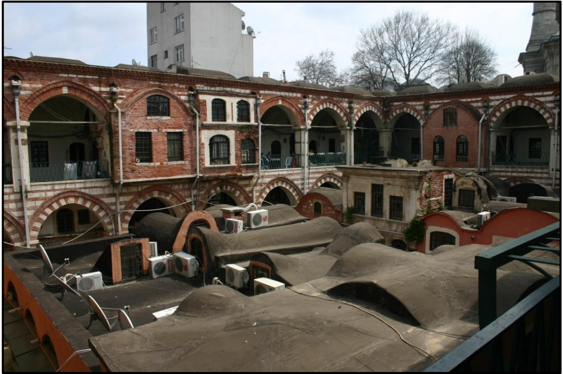
Çuhacı Hanın Avlusuna Sonradan Yapılan Yapılar (Kişisel Arşiv)
