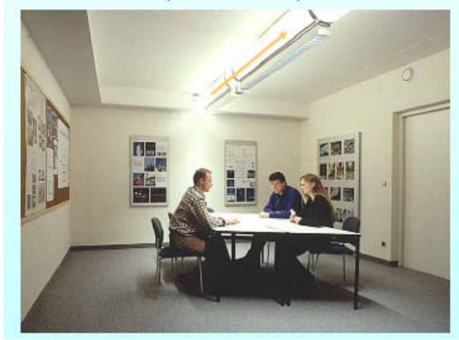
Şekil 5.25. Işık kılavuzu ile taşınan ışığın iç hacimde kullanılması
