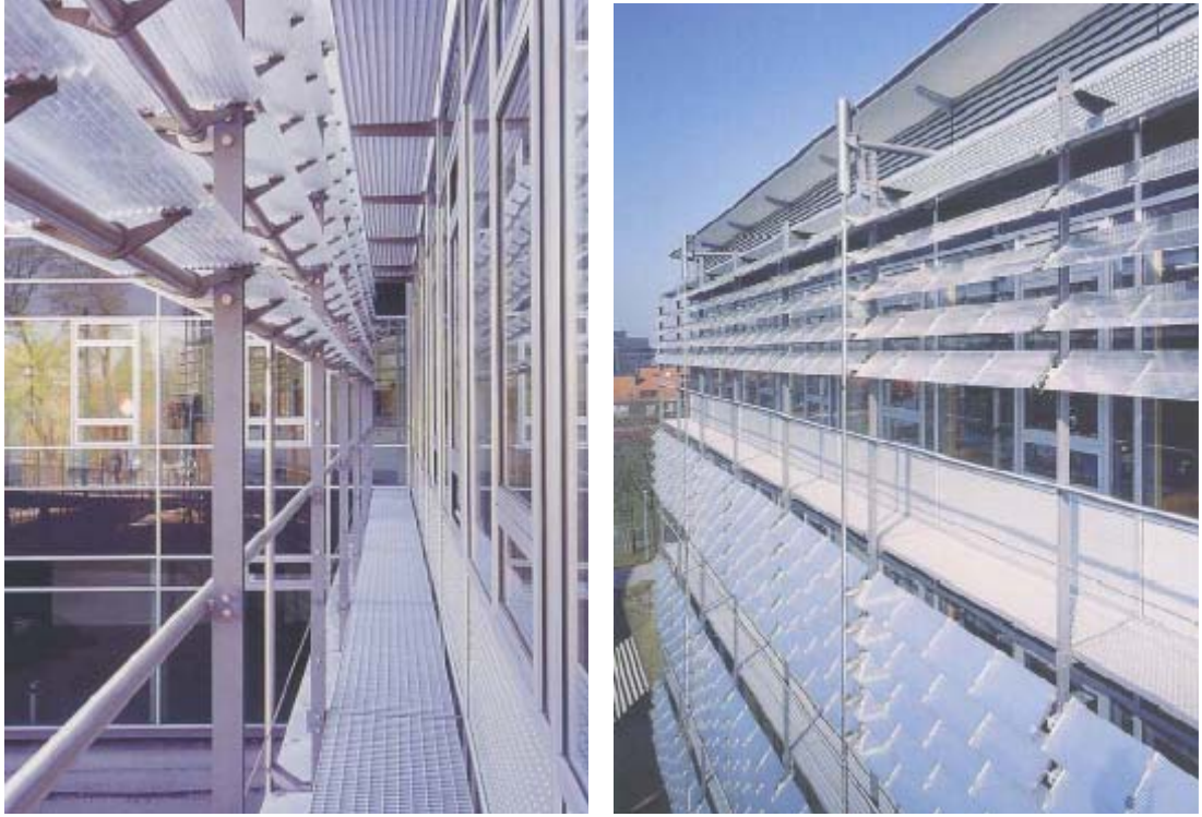
Şekil 5.9. Prizmatik panellerle uygulanmış gölgeleme sistemi
