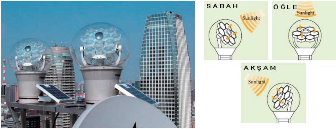
Şekil 5.32. Himewari sistemi güneş toplayıcı (heliostat)
