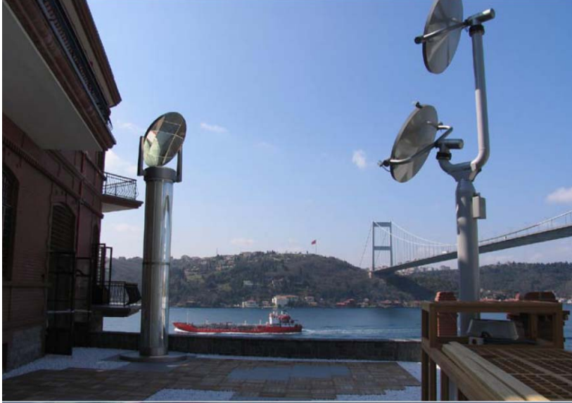
Şekil 5.18. Yusuf Ziya Paşa Köşkü (Perili Köşk) Borusan Holding Yönetim Binası heliostat uygulaması -İstanbul
