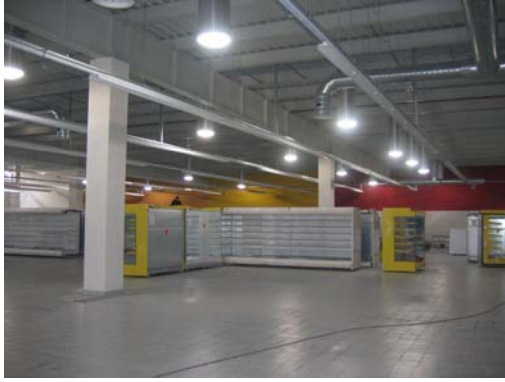
Şekil 5.28. Salihlide Hipermarket uygulaması 124 adet gün ışığı tüpü uygulaması Şekil 5.29. Adapazarı gün ışığı tübü ile ofis aydınlatması (60x60 kare model)
