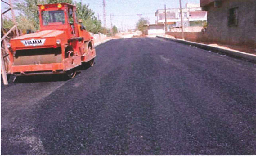
ŞEKİL 1.26 : Asfalt yapımı. (www.inşaatmühendisliği.net)
