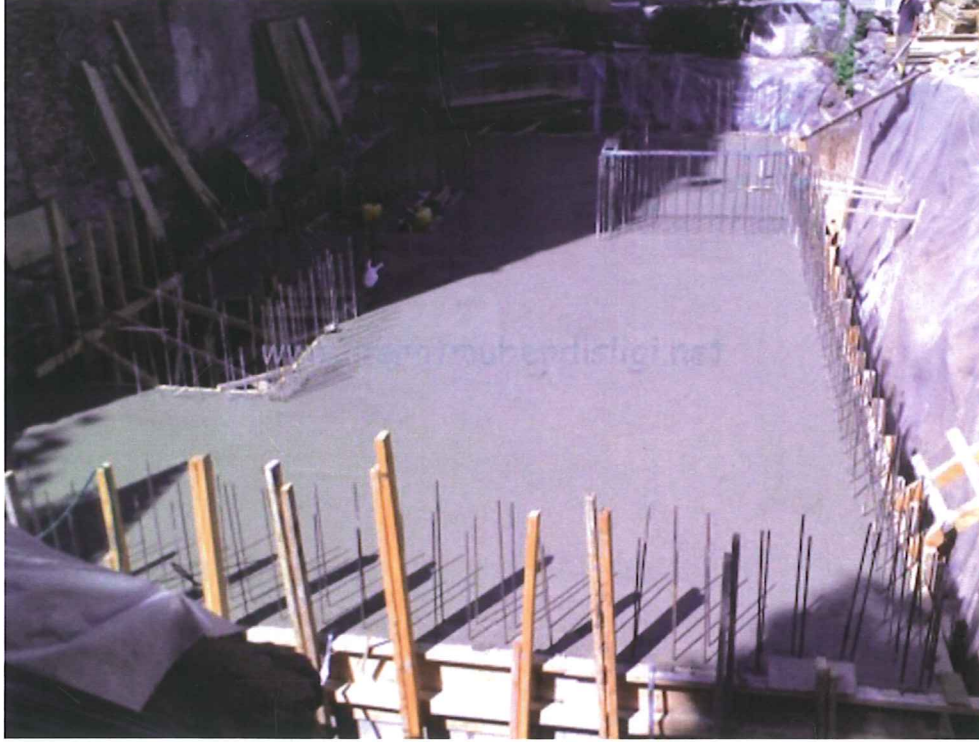
ŞEKİL 1.25 : Dökme betonun uygulama şekline ait bir örnek. (www.inşaatmühendisliđi.net)
