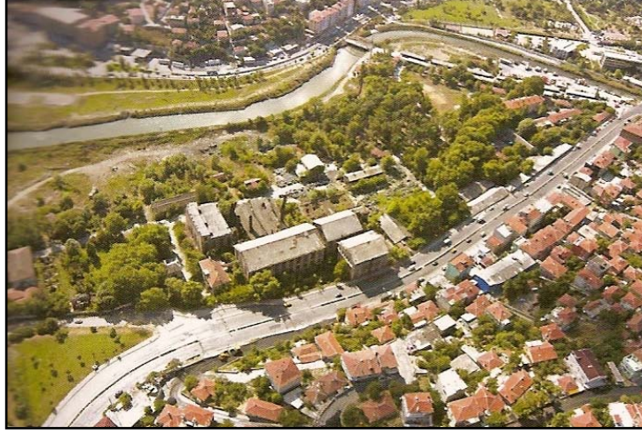
Şekil 5.1. Silahtaraga Elektrik Santrali'nin Yukarıdan Görünüm
