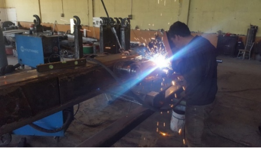
Resim 5 Yardımcı sase kaynağı yapılırken
