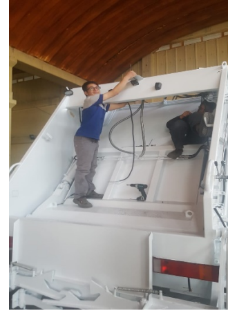
Resim 8 Elektrik tesisatı yapılırken
