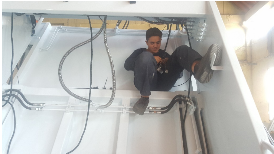
Resim 11 Ekipmana elektrik tesisatı ekilmesi
