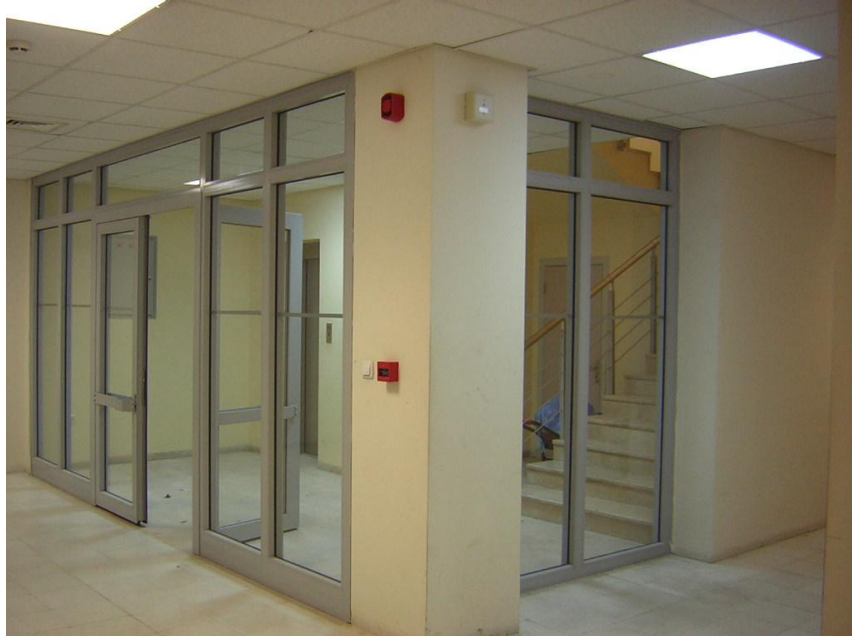
Şekil 4.39. Binanın tümünde kullanılan alüminyum doğramaların, tavan zemin ve taşıyıcı eleman ilişkisinin zemin kattan görünümü.
