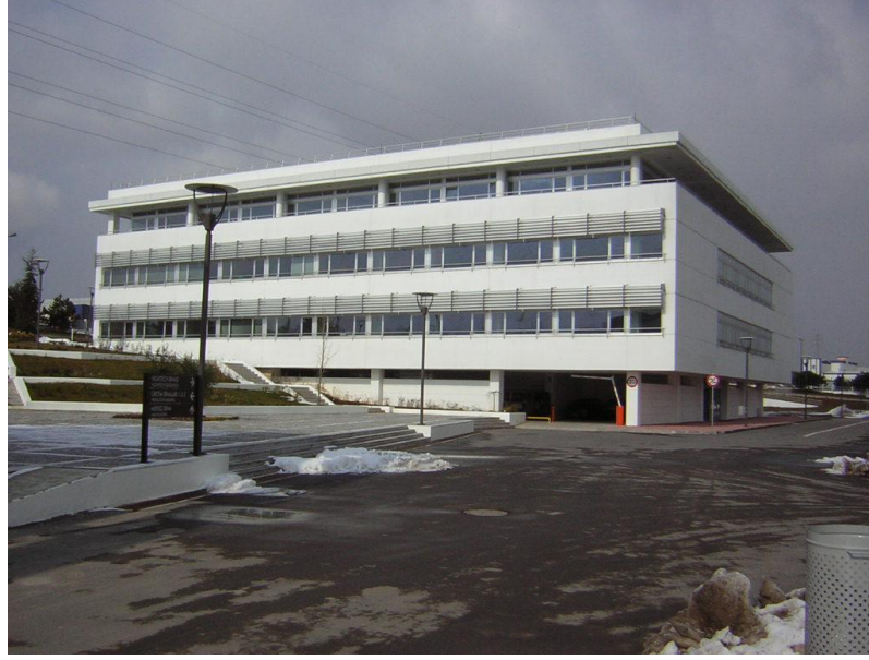
Şekil 4.2. İnkübatör (Kuluçka) binasının görünümü
