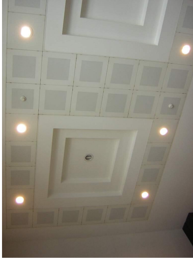
Şekil 4.55. Binanın giriş bölümünün tavan sistemi
