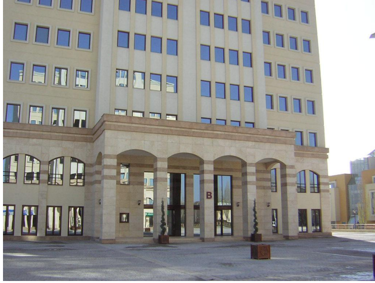
Şekil 4.52. Bilkent CyberPark binasının görünümü
