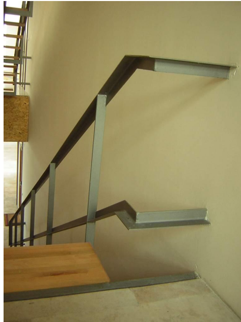
Şekil 4.50. Merdiven trabzanından detay
