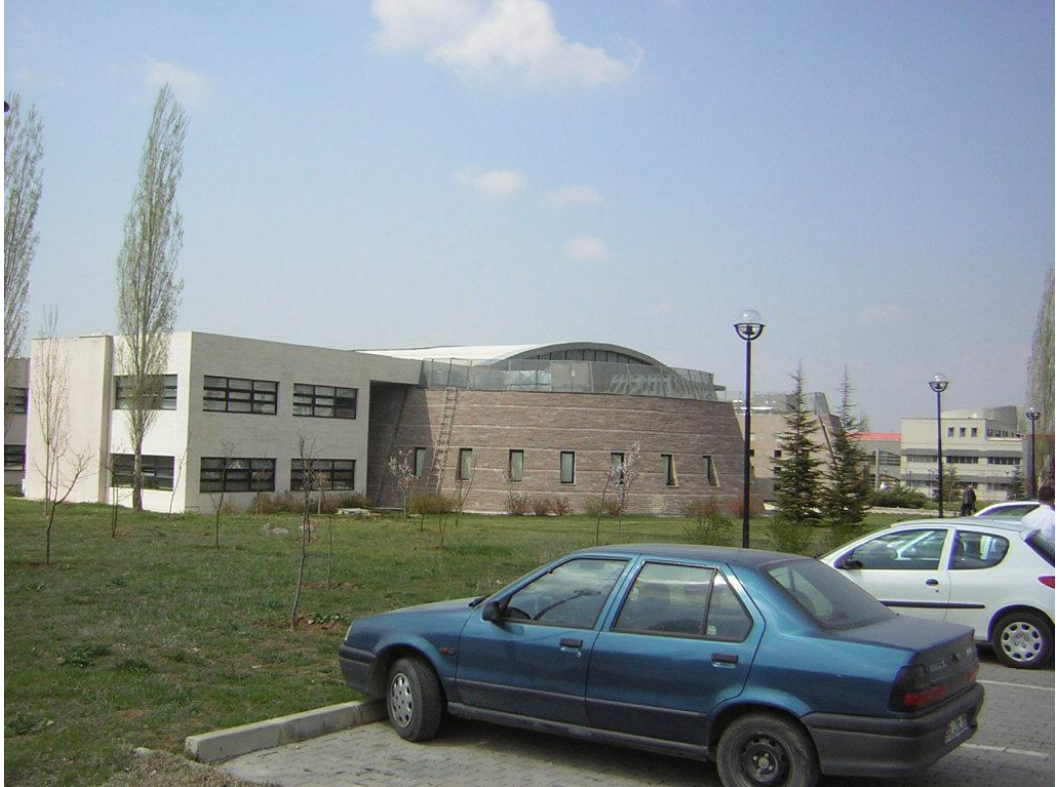
Şekil 4.22. ODTÜ İkizleri yönetim binasının görünümü
