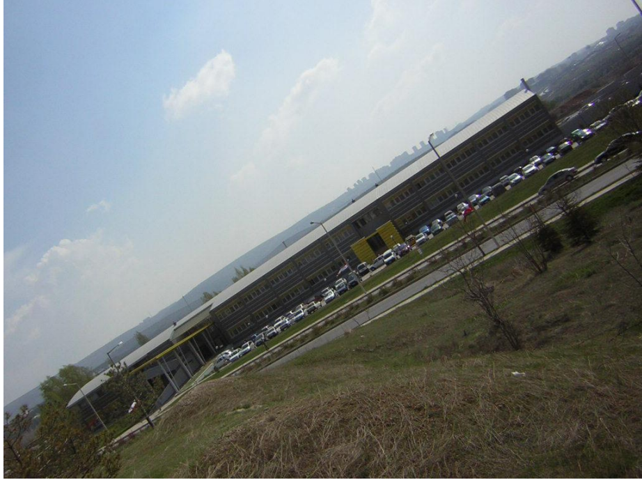
Şekil 4.33. Gümüş Bloklar'ın kuzey cephesinden görünüm
