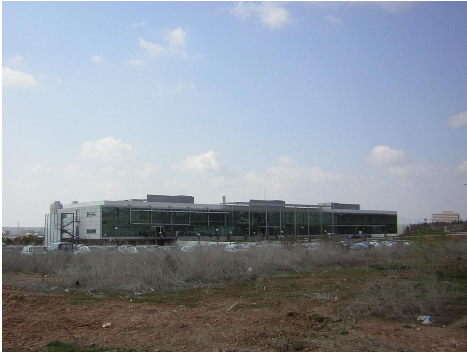
Şekil 4.41. Silikon Blok Binasının görünümü
