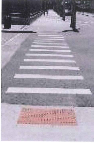
Resim 6: Rampa sonuna yerleştirilen kaymayı önleyici satırlar
