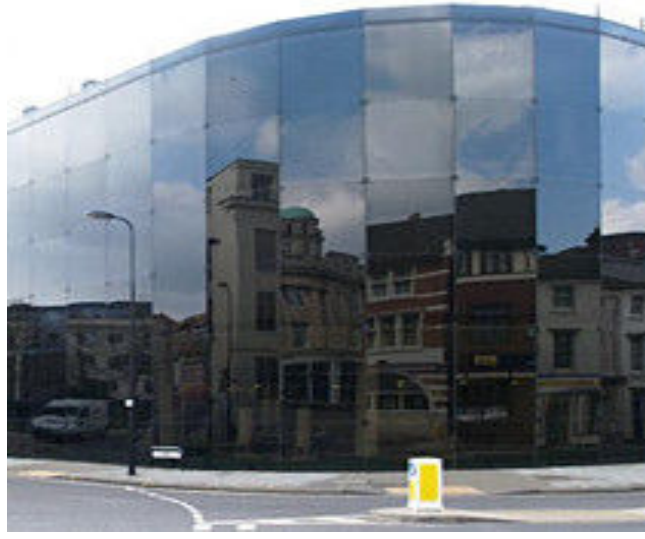
Resim: 2.2. Yönetim Binası-Cam Duvarları, Willis Faber&Dumas (Wigginton, 1996)
