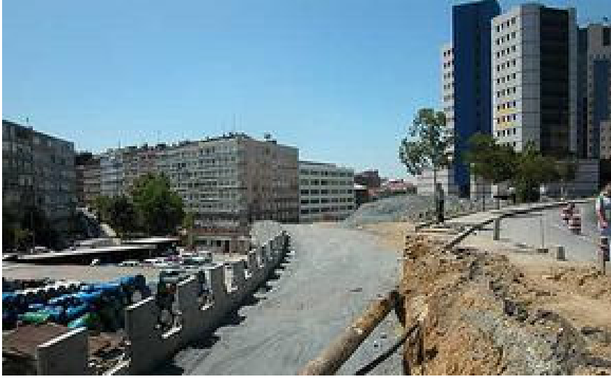
Fotoğraf 27: Şişli-Feriköy-Dereboyu Caddesi Bağlantı yolları ve ortak altyapı inşaat süreci
