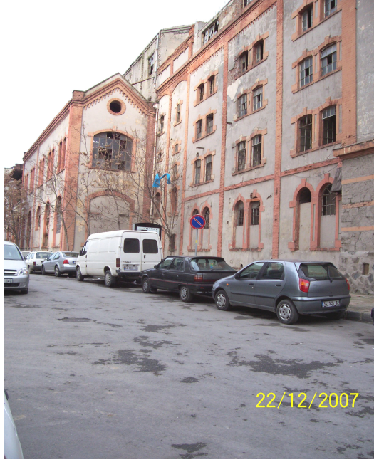
Fotoğraf 1: Silahşörler Caddesi Eski Tekel Bira Fabrikası (Restore edilecek kısım)
