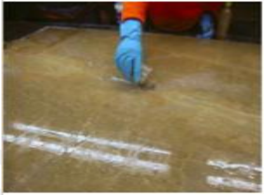
Resim 19: Küçük parçalar ile çatlak doldurma
