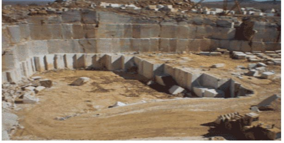
Şekil 9: Çukur Şekilli Rampa Yol Sistemli Açık Ocak Doğal Taş İşletmesi (Demircioğlu Mermer )
