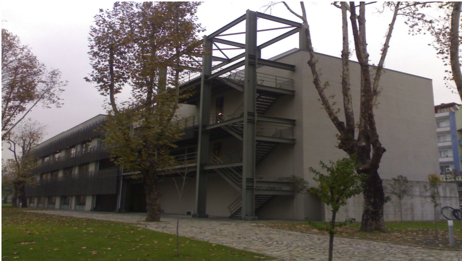
Şekil 3.57 Silahtarağa Elektrik Santrali – İstanbul Bilgi Üniversitesi (Bürkan Emre Arşivi)
