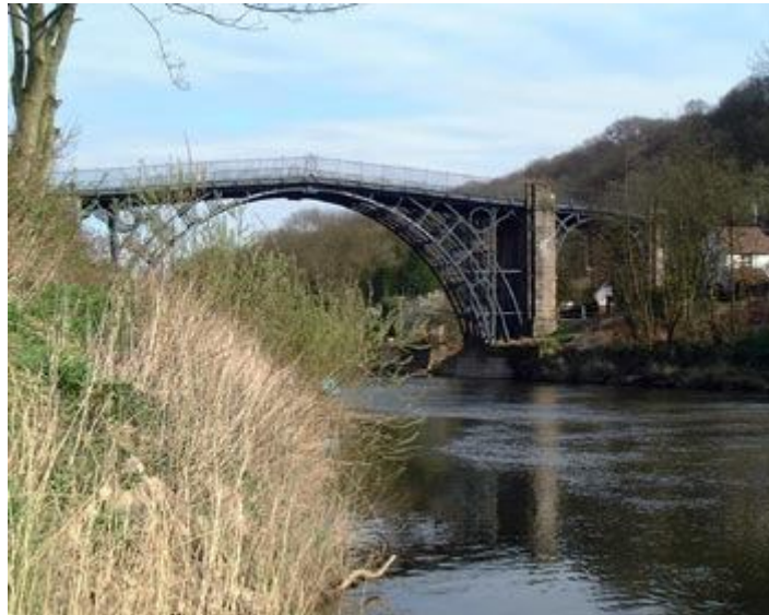
Şekil 1.14 T.F. Pritchard'ın Demir Köprüsü
