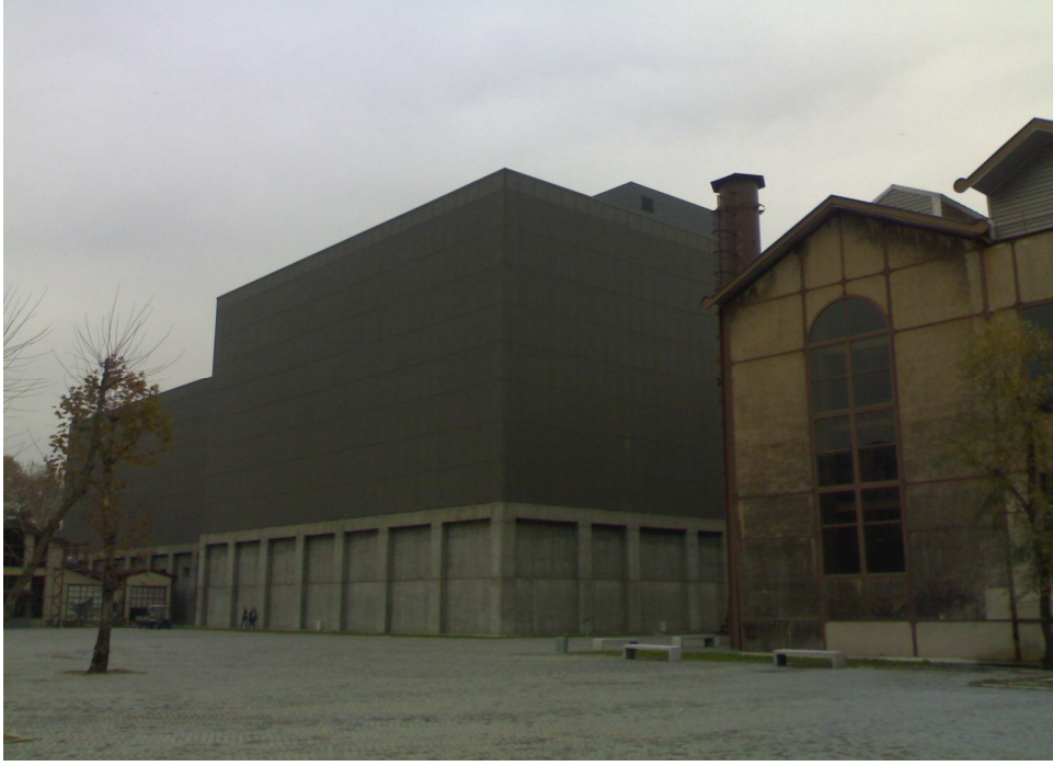
Şekil 3.51 Silahtarađa Elektrik Santrali - Santral İstanbul Günümüz (Bürkan Emre Arşivi)
