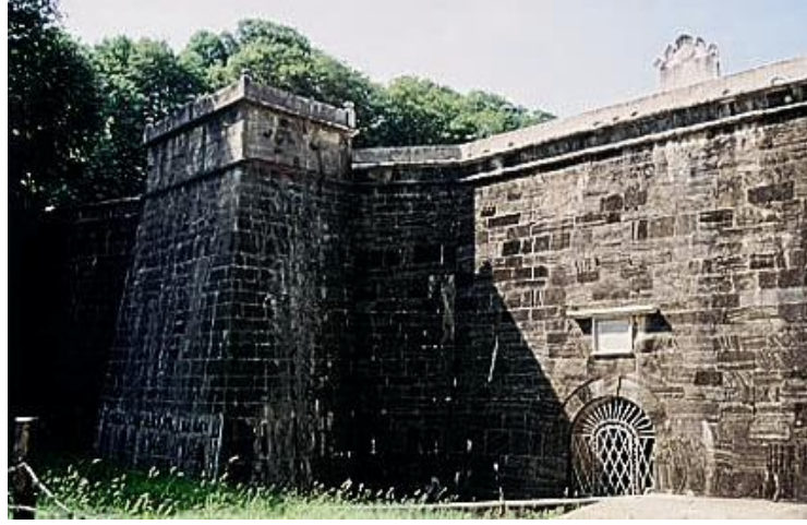
Şekil 3.19 Taksim Su Tesisi
