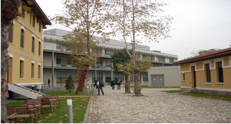
Şekil 3.56 Silahtarağa Elektrik Santrali – İstanbul Bilgi Üniversitesi (Bürkan Emre Arşivi)
