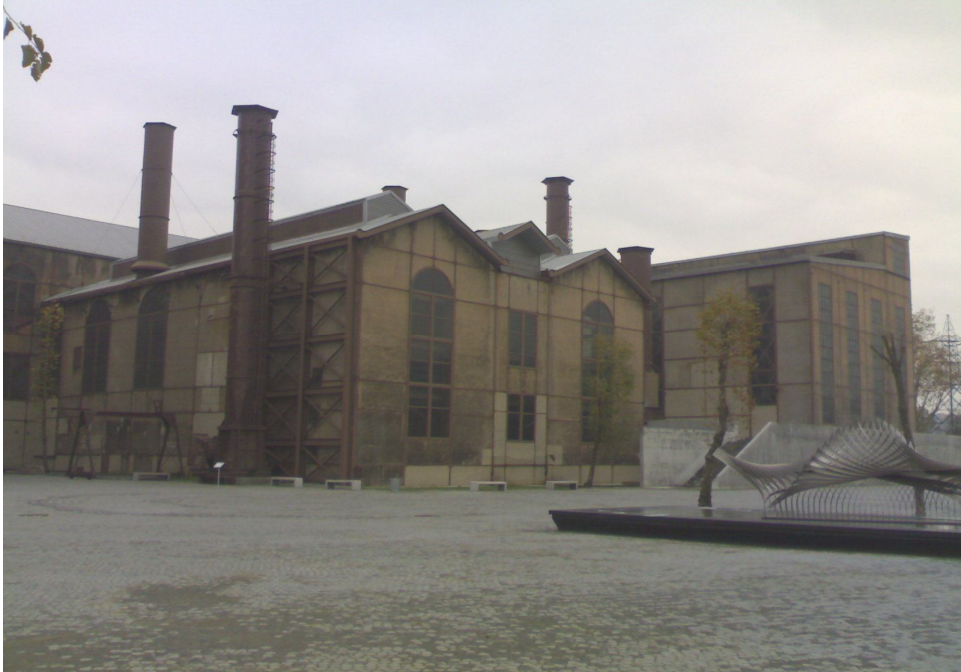
Şekil 3.50 Silahtarağa Elektrik Santrali - Santral İstanbul Günümüz (Bürkan Emre Arşivi)
