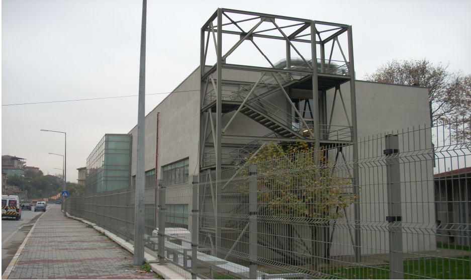
Şekil 3.59 Silahtarağa Elektrik Santrali – İstanbul Bilgi Üniversitesi (Bürkan Emre Arşivi)
