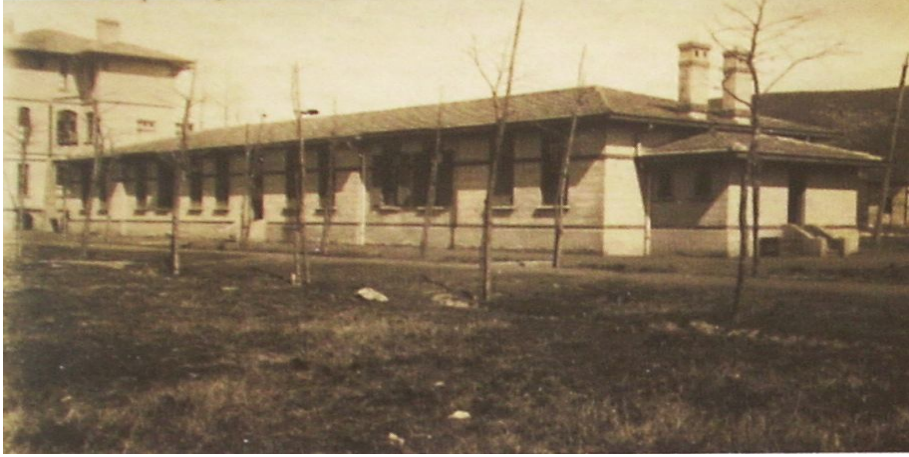
Şekil 3.41 Silaharağa Elektrik Santrali Tek Katlı Lojmanları
