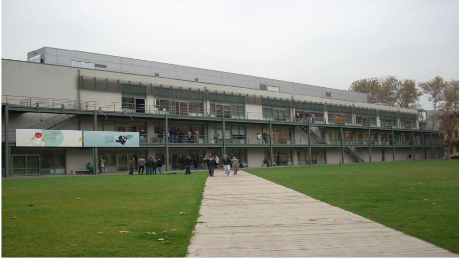
Şekil 3.55 Silahtarağa Elektrik Santrali – İstanbul Bilgi Üniversitesi (Bürkan Emre Arşivi)
