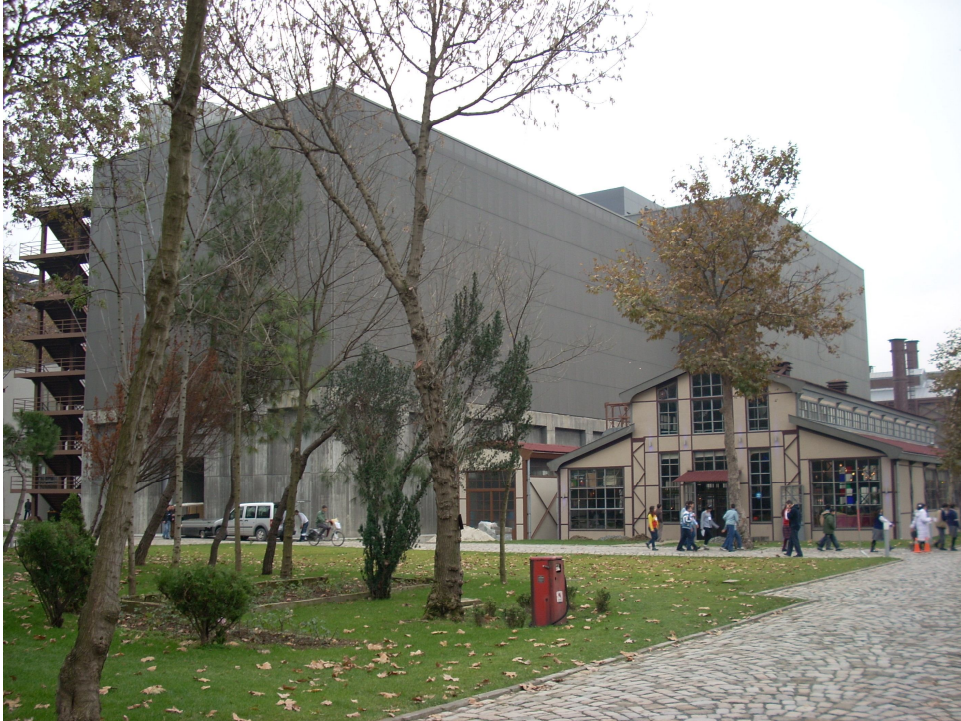
Şekil 3.52 Silahtarađa Elektrik Santrali - Santral İstanbul Günümüz (Bürkan Emre Arşivi)
