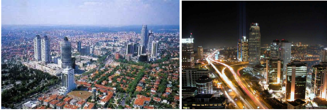
Resim 4.11- 4.12. Levent'in yeni yapılaşmalarının gece ve gündüz görünüşü (kaynak: 4.11-10.11.2003, Hürriyet; 4.12- flickr.com)
