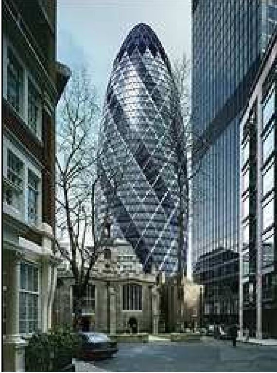
Şekil 4.13. Swiss-Re Binası (Londra, 1997-2004) Ofis Binası
