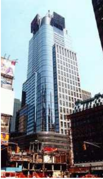
Şekil 4.12. Conde Nast (New York) Ofis Binası
