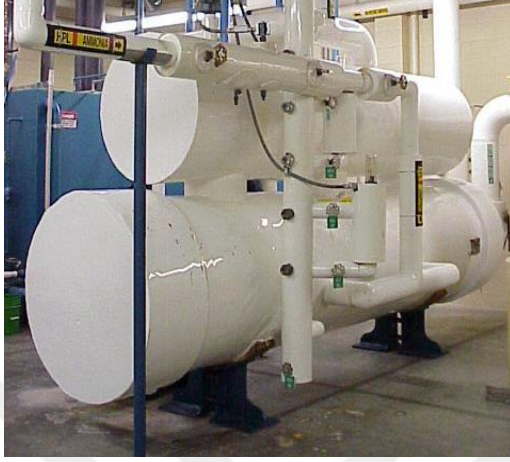
Huzme borulu sıvı soğutucu plaka ve çerçevesel sıvı soğutucu
