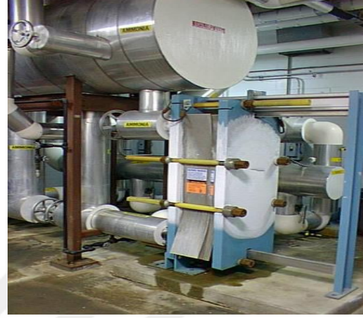
Huzme borulu sıvı soğutucu plaka ve çerçevesel sıvı soğutucu
