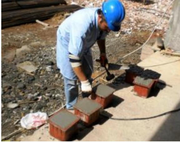
Şekil 9: Hazır Beton Numune Alma
