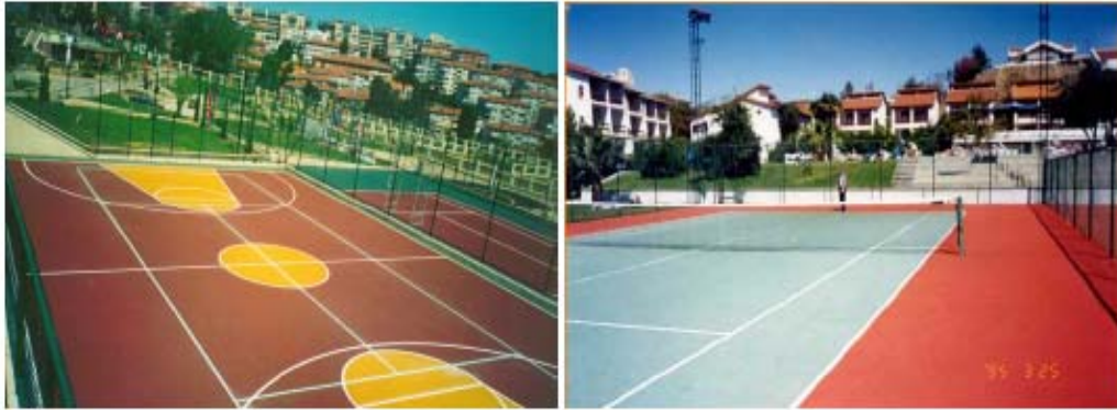
Şekil 2. 33. Renkli desenli asfaltın basketbol sahası ve tenis kortundaki uygulama örneği (www.imkar.com.tr)
