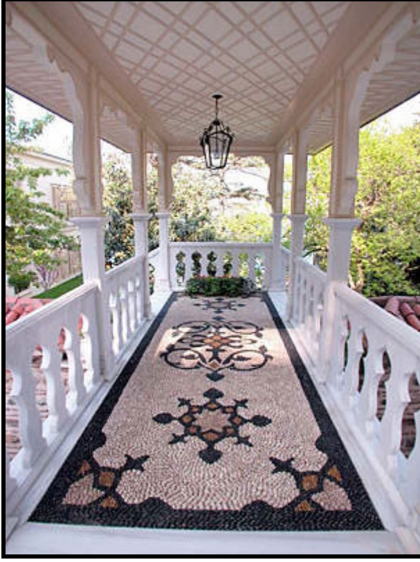
Şekil 2. 34. Çakıl mozaik taşlarla oluşturulmuş döşeme uygulama örneği ( www.evdose.com )
