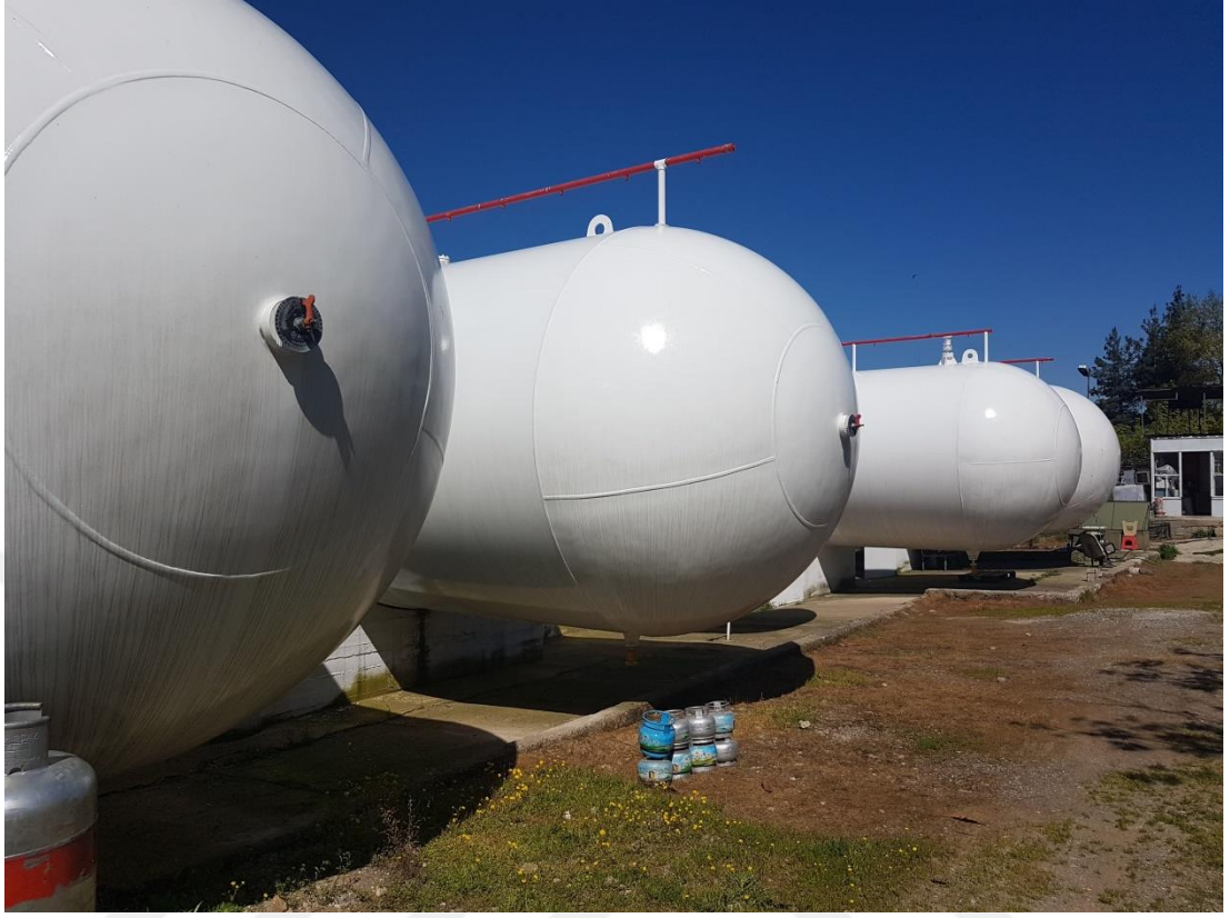
Şekil 3. 180m 3 Kapasiteye Sahip LPG Tankları
