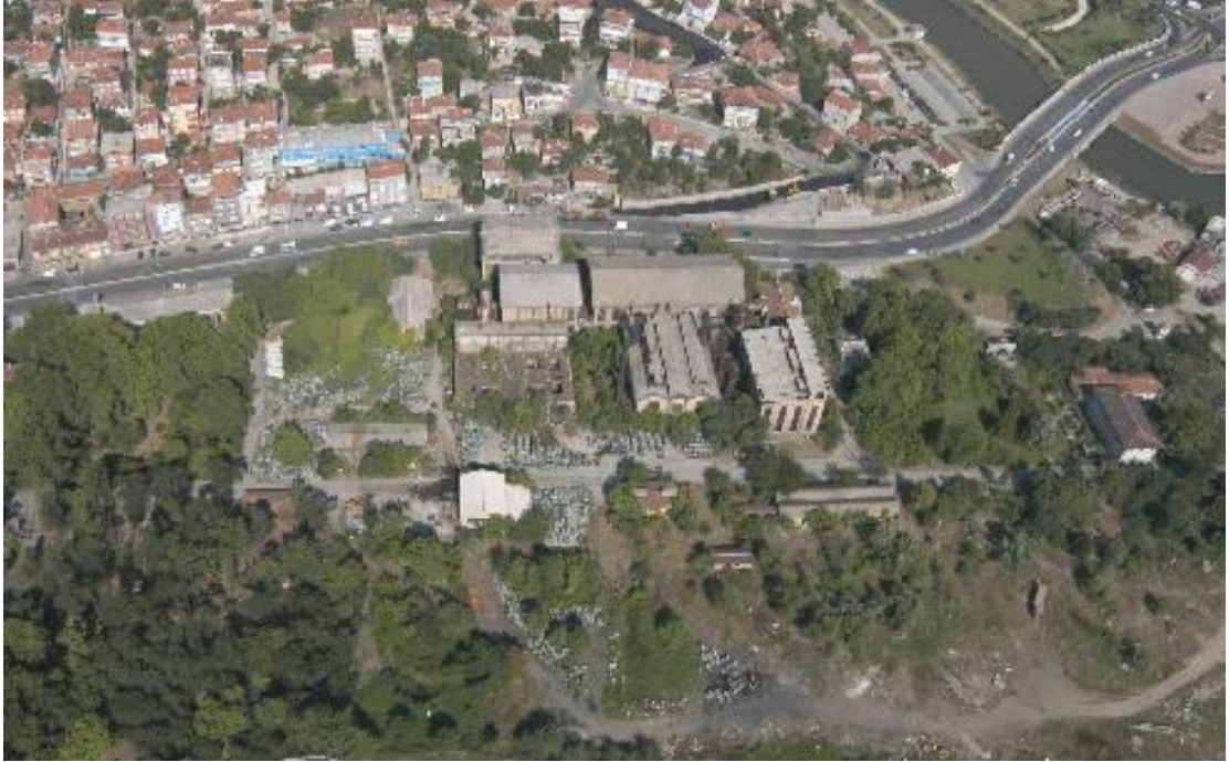
Şekil 5 Silahtarağa Elektrik Santrali
