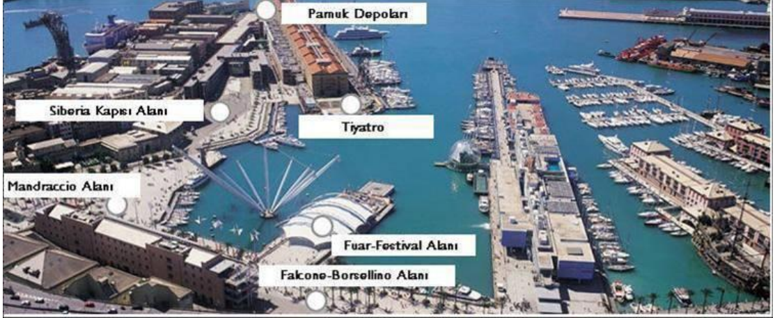
Şekil 41 Cenova Limanında Yapılan Düzenlemeler
