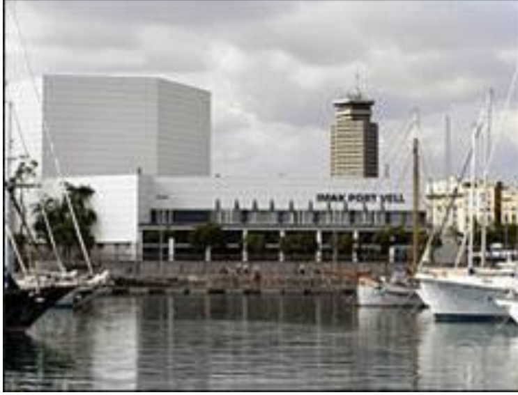
Şekil 27 Barselona Limanı Sinema Binası
