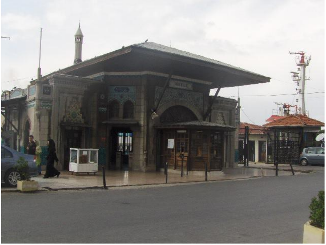
Şekil 48 Haydarpaşa İskele Binası 2008
